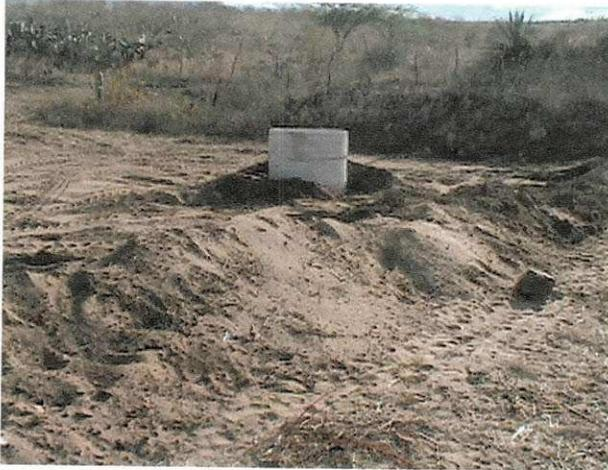
**Figura A.9** Barragem subterrânea totalmente finalizada com o poço a montante.
