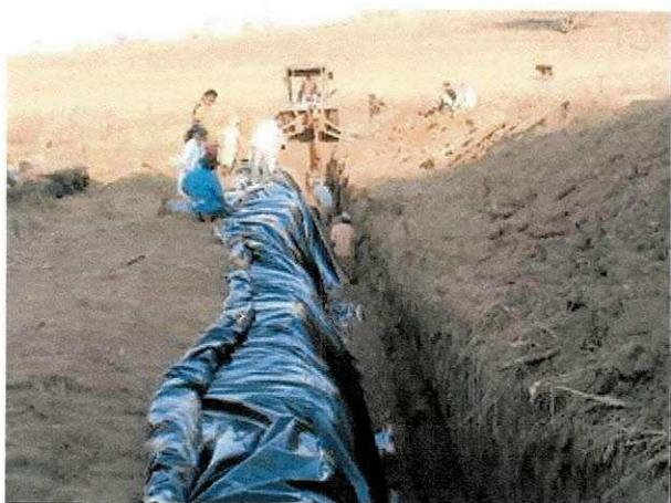
**Figura A.7** Colocação da lona plástica de 200 micras, 6 m de largura dentro da vala.
