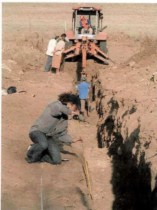
**Figura A.5** Medição da profundidade da vala para conhecimento do perfil da barragem subterrânea.
