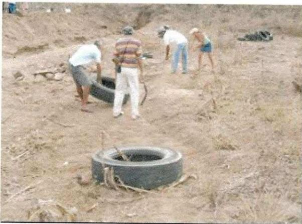
**Figura A.11** Preparação para o barramento com pneus usados no lado jusante da barragem subterrânea.
