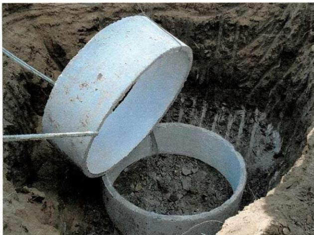
**Figura B.5** Colocação dos anéis pré-moldados para a construção do poço amazonas.
