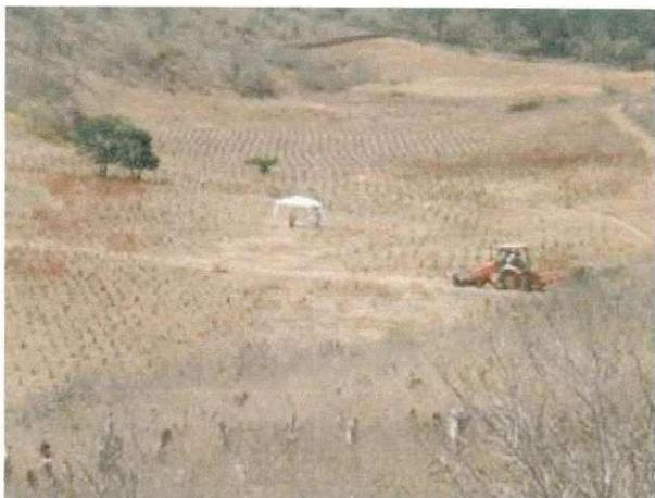
**Figura A.1** Início da construção da barragem, sendo o risco branco transversal à limpeza do terreno para melhor movimentação das pessoas ao longo da vala.
