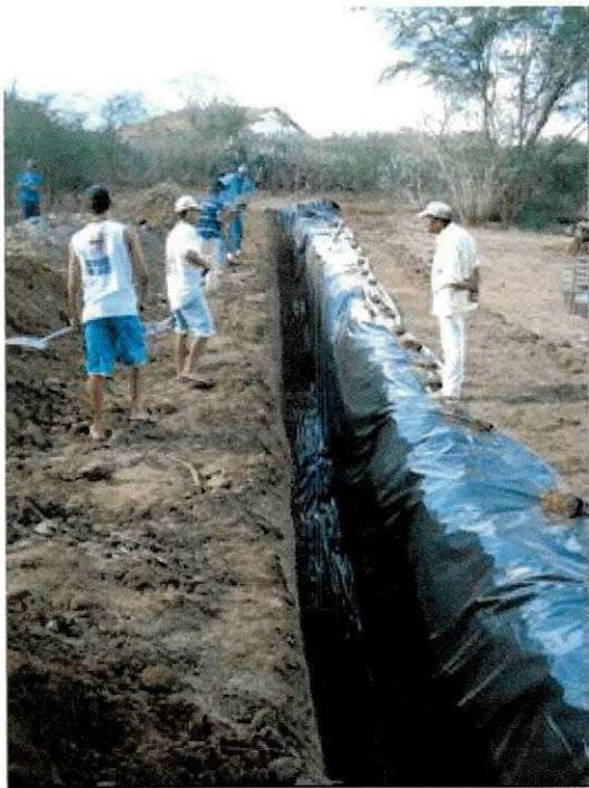
**Figura B.3** Colocação da lona plástica com 200 micras, para preenchimento da vala com solo anteriormente escavado.
