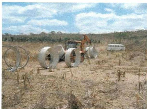
**Figura A.8** Colocação dos anéis pré-moldados no campo, para realização do poço amazonas.
