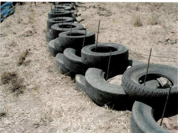
**Figura C.5** Barramento de pneus usados, preenchido com pedra e varas de  $\frac{1}{2}$  polegada
