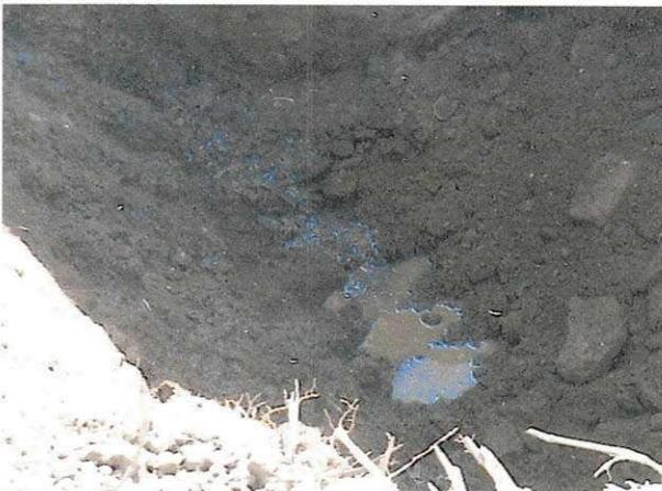
**Figura C.3** Escavação do poço amazonas com água aflorando
