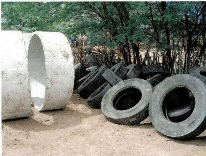
**Figura B.4** Colocação dos anéis pré-moldados no campo e pneus usados, para posterior construção do poço amazonas e BAPUCOSA respectivamente.
