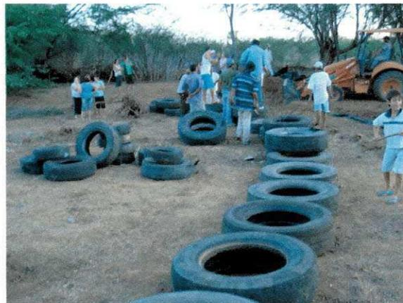
**Figura B.6** Construção do barramento com pneus usados
