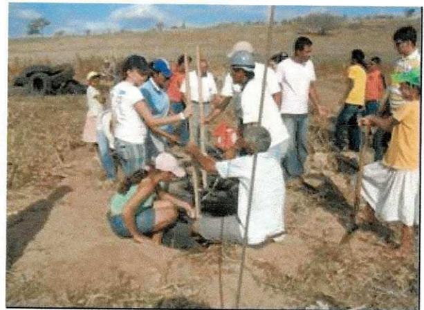
**Figura A.12** Realização das leituras de nível da primeira camada de pneus ao solo.
