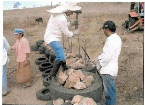
**Figura A.14** Colocação das varas de ferro  $\frac{1}{2}$  polegada, dentro dos pneus para maior sustentabilidade.
