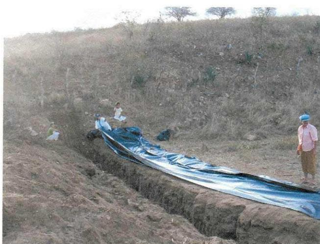
**Figura A.6** Colocação da lona 200 micras ao longo da vala da barragem subterrânea.
