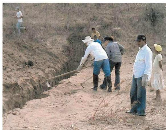
**Figura A.4** Limpeza da lateral da vala para colocação da lona plástica.
