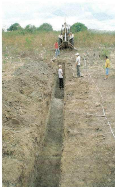
Figura 32 - Escavação da barragem subterrânea.
