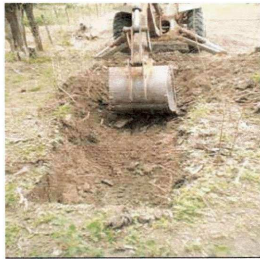
Figura 7 - Inicia da escavação da barragem.
