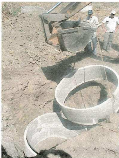
Figura 37 – Descida dos anéis.
