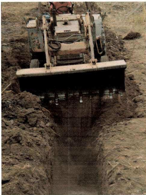
Figura 27 - Fechamento da barragem.
