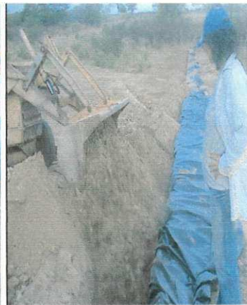
Figura 43 – Fechamento da barragem.
