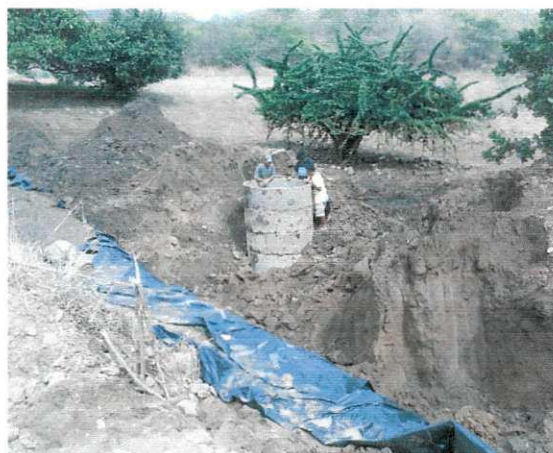
Figura 30 - panorâmica da área antes do total fechamento.
