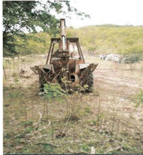
Figura 5 - Máquina limpando o local onde vai ser escavação da barragem.
