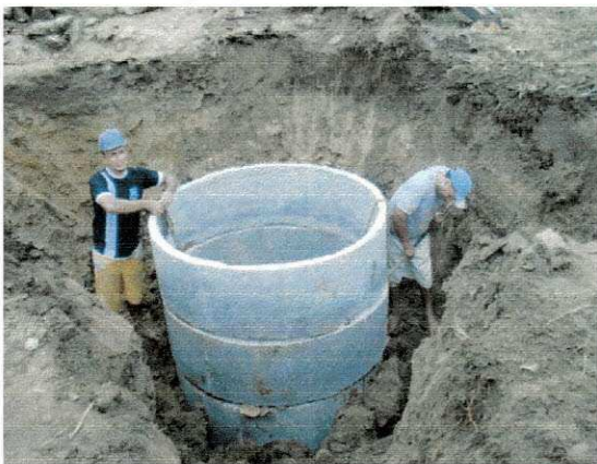
Figura 18 - uso da lanca para acomodação dos anéis.
