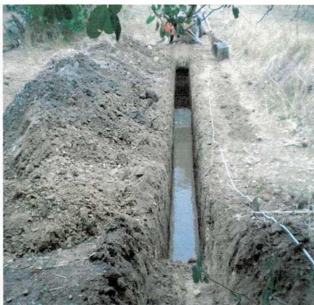
Figura 24 - Grande quantidade de água dentro da Barragem.
