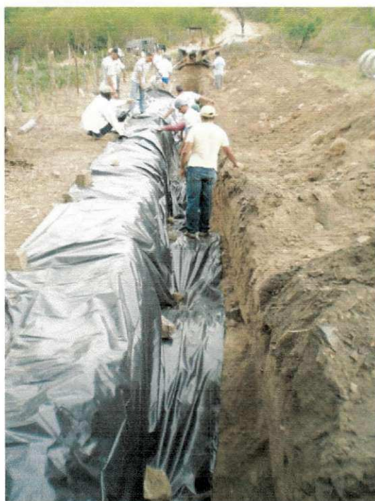
Figura 11 - colocação da lona com o auxílio de pedras. Figura 12 – colocação da lona.
