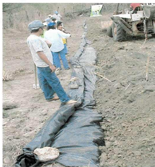
Figura 36 - Fechamento da barragem.
