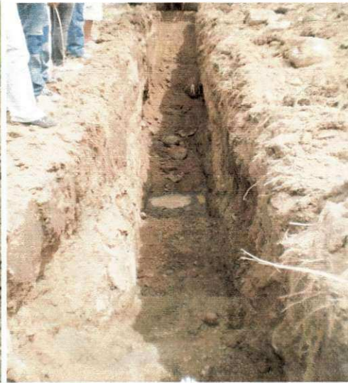
Figura 9 - Mostra o discreto aparecimento de água identificando onde seria o leito do rio.
