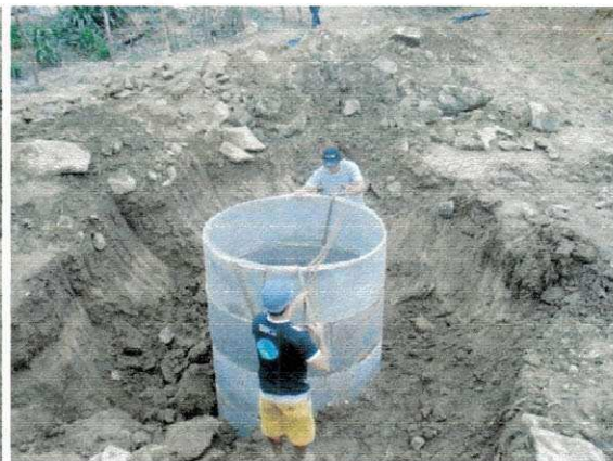
Figura 19 - colocação do ultimo anel.
