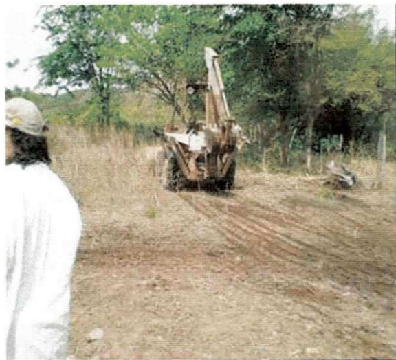
Figura 6 - Máquina limpando o local da construção.
