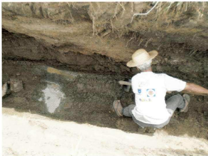
Figura 10 - O senhor Jose Clarindo limpando o fundo da barragem para uma melhor vedação.
