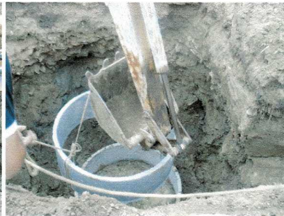
Figura 17 - descida do segundo anel.
