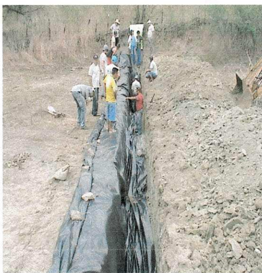
Figura 35 – Colocação da lona na vala.
