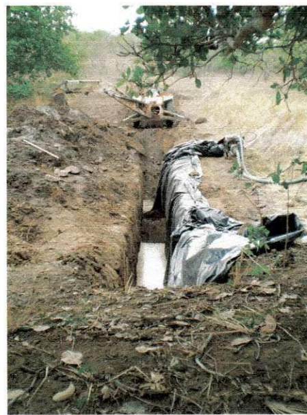
Figura 28 - Reconstrução da barragem colocando logo a lona.
