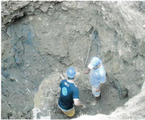
Figura 14 - limpeza para acomodação do 1º anel.
