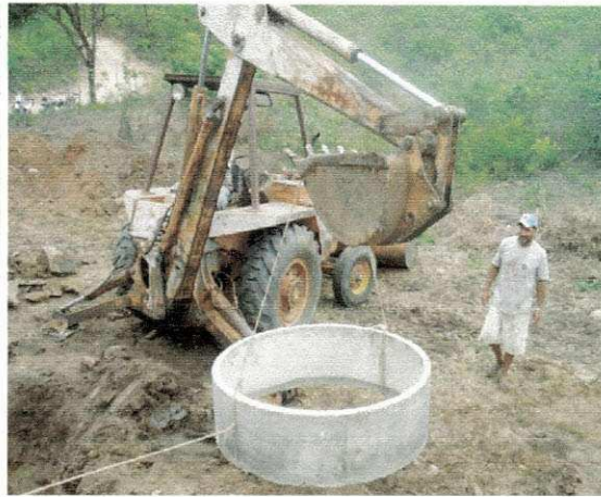
Figura 15 - amarração e colocação do 1º anel.
