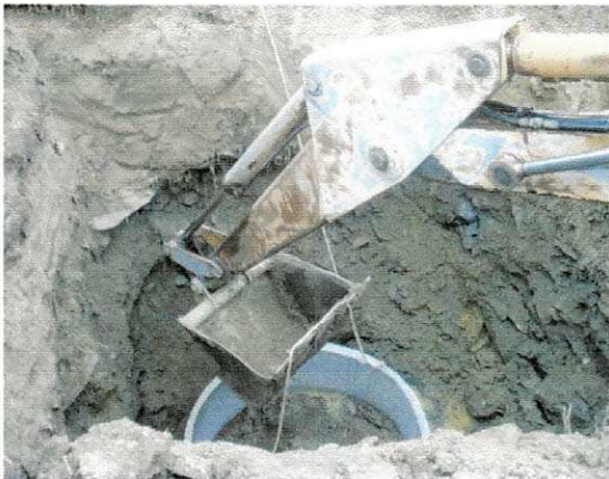
Figura 16 - descida do primeiro anel.
