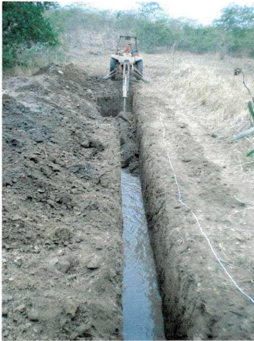
Figura 25 – Momento em que a barreira desmorona.
