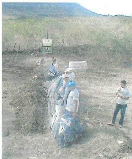
Figura 38 - vista da barragem próximo ao termino.
