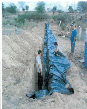
Figura 42 – Escavação e Colocação da lona
