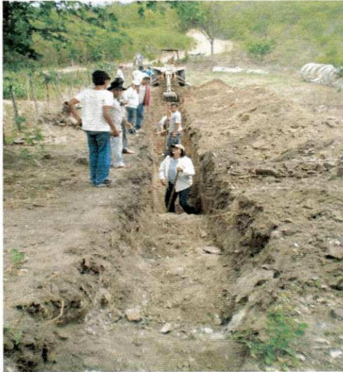
Figura 8 - Mostra o início da escavação.
