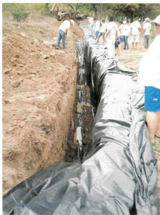
Figura 11 - colocação da lona com o auxílio de pedras. Figura 12 – colocação da lona.
