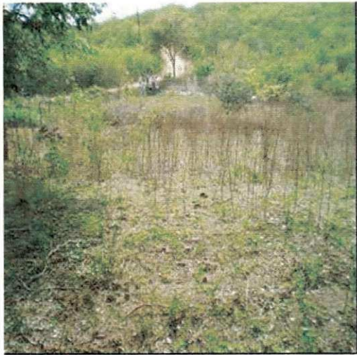
Figura 4 - Área a ser construída a primeira barragem antes de ser limpa.
