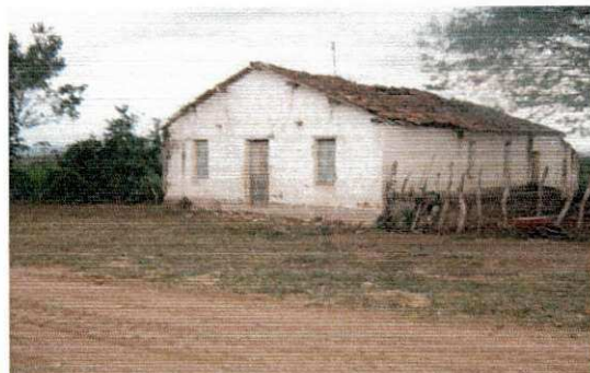
Figura 9: Casa sede, construída na década de 40
