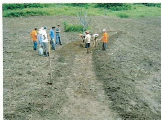
**Figura 23.** Rebaixamento pra colocação da 1ª camada de pneus.
