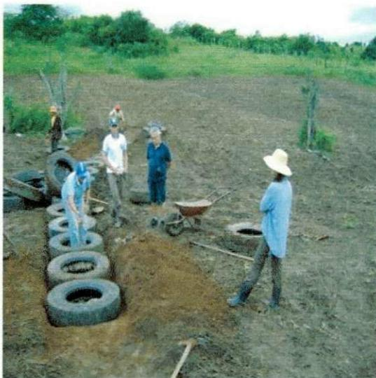
**Figura 25.** Colocação de pedras no interior dos pneus.
