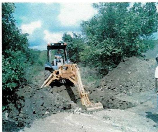
**Figura 32.** Escavação para a colocação dos anéis de concreto do segundo poço.
