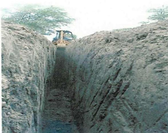
**Figura 15b.** Vista das ranhuras nas paredes da vala no solo argiloso.
