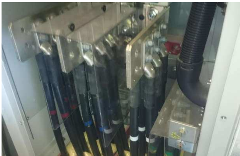
Figura 15: Caixa de passagem localizada dentro da torre do aerogerador.
