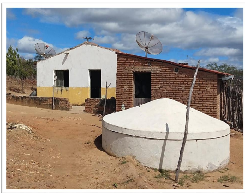
Figura 1: Cisterna de placa para armazenamento de águas das chuvas.
