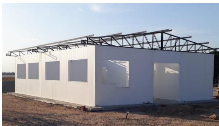
Figura 2 – Bloco administrativo construído com sistema concreto- PVC
