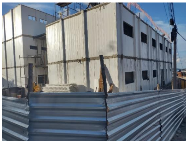
Figura 3 – Escola dois pavimentos construída em Gravatá- PE
