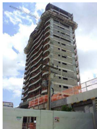
Figura 15 — Segunda torre do condomínio em construção.
