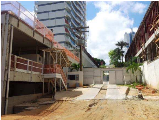
Figura 12 — Subestação clandestina conectada em MT, no interior de condomínio vertical.
