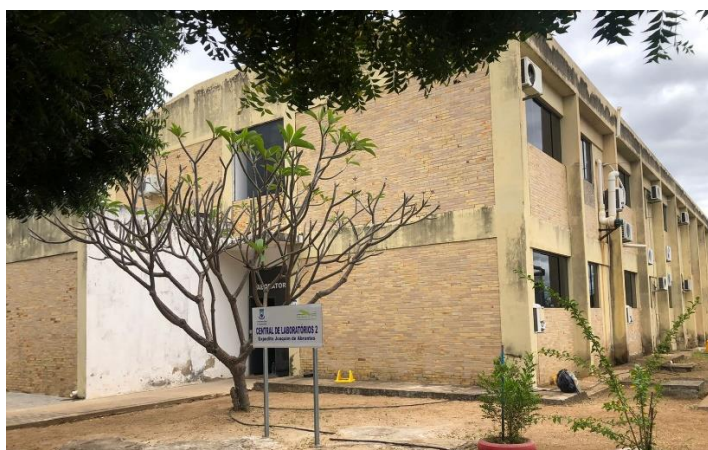
Figura 7 – Central de Laboratórios II (Fonte: Autor; 2022)
