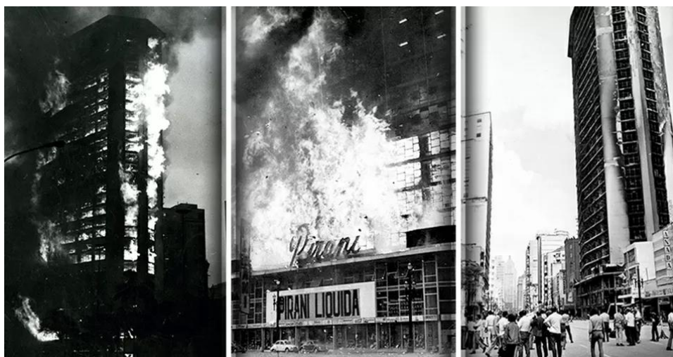
Figura 12 – Incêndio Edifício Andraus. (Fonte: Uol; 2013)
