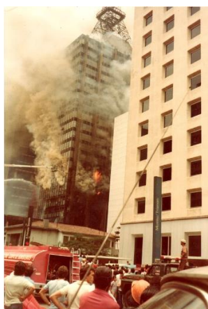
Figura 15 – Incêndio Edifício Grande Avenida (Fonte: serieavenidapaulista.com.br; 2019)
