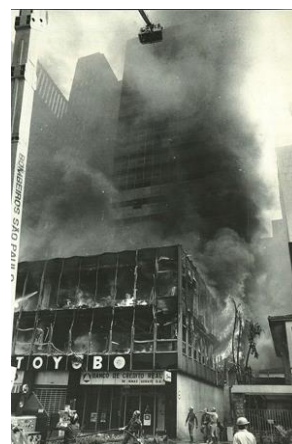
Figura 16 – Incêndio Edifício Grande Avenida (Fonte: Uol; 2015)
