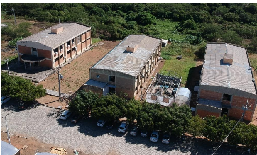
Figura 3 - Centrais de Laboratórios I, II e III (Fonte: Autor; 2022)
