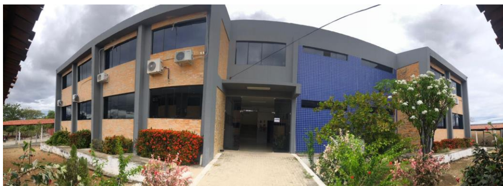
Figura 4 – Central de Aulas I (Fonte: Autor; 2022)
