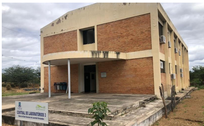
Figura 8 – Central de Laboratórios III (Fonte: Autor; 2022)
