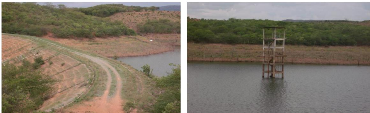
Figura 10: Açude Prazeres, Barro – CE
