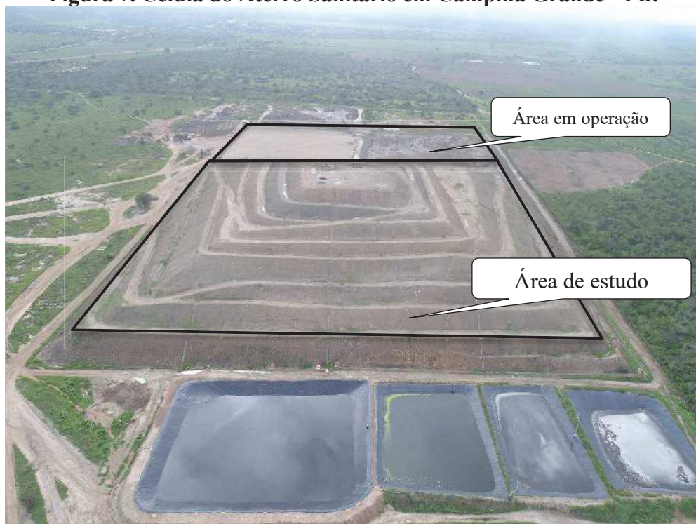
Figura 7. Célula do Aterro Sanitário em Campina Grande - PB.
