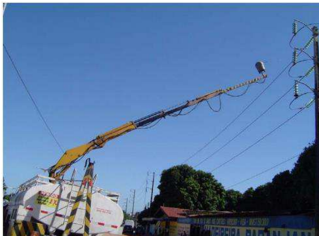
Figura 13 - Fotografia da lavagem de isolador com linha viva, sistema convencional com robô instalado em um guindauto de um caminhão.
