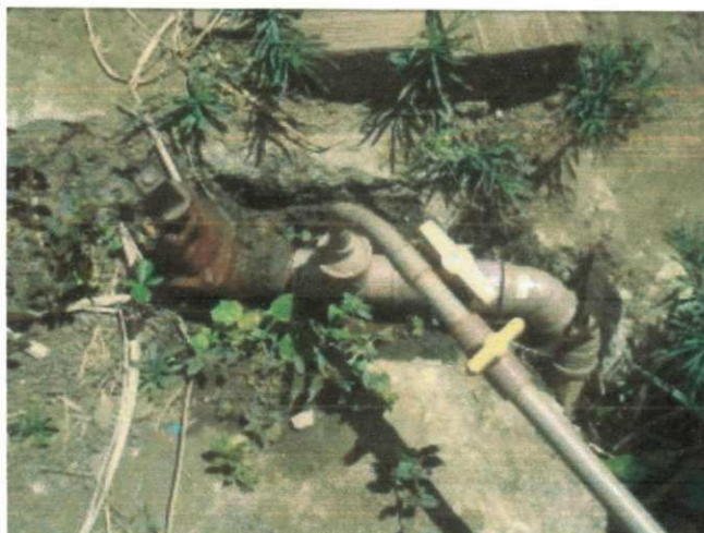
Figura 19 – Ligações de água improvisadas no campus Campina Grande da UFCG.
