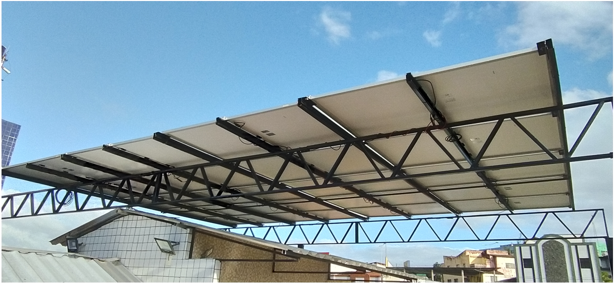
Figura 23 – Estrutura projetada para instalação de módulos fotovoltaicos.
