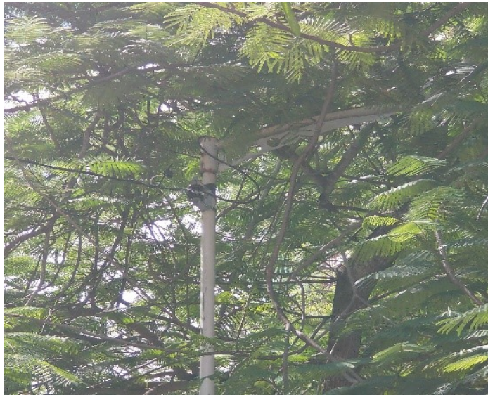
Figuras 8: Contato entre árvores e luminárias.
