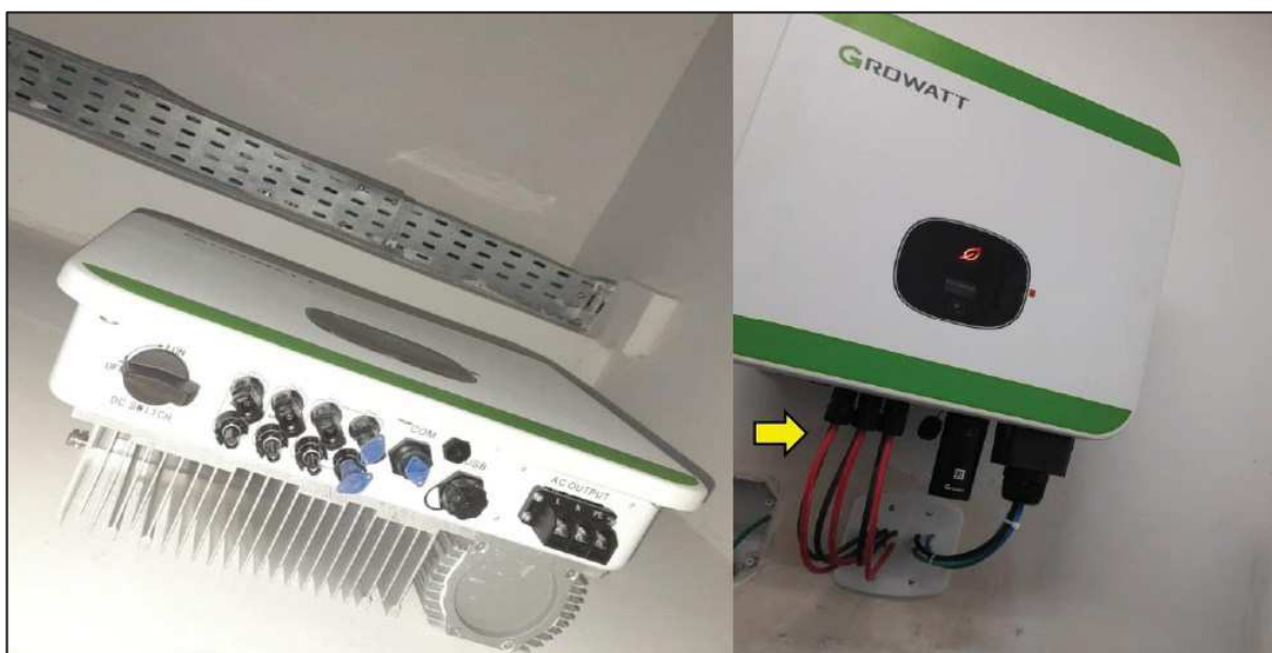
Figura 37. Conectores do inversor (a) e conexão das strings (b)
