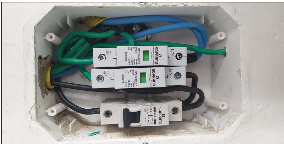
Figura 34. Instalação do quadro de proteção CA.
