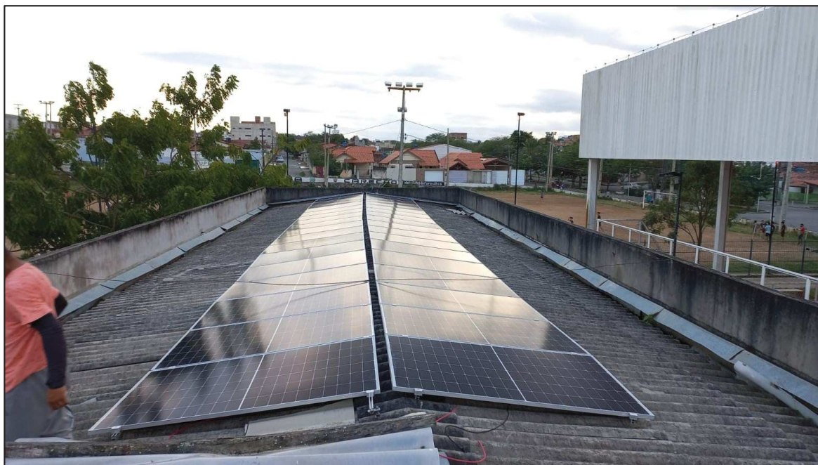
Figura 32. Instalação dos módulos fotovoltaicos no telhado da edificação.
