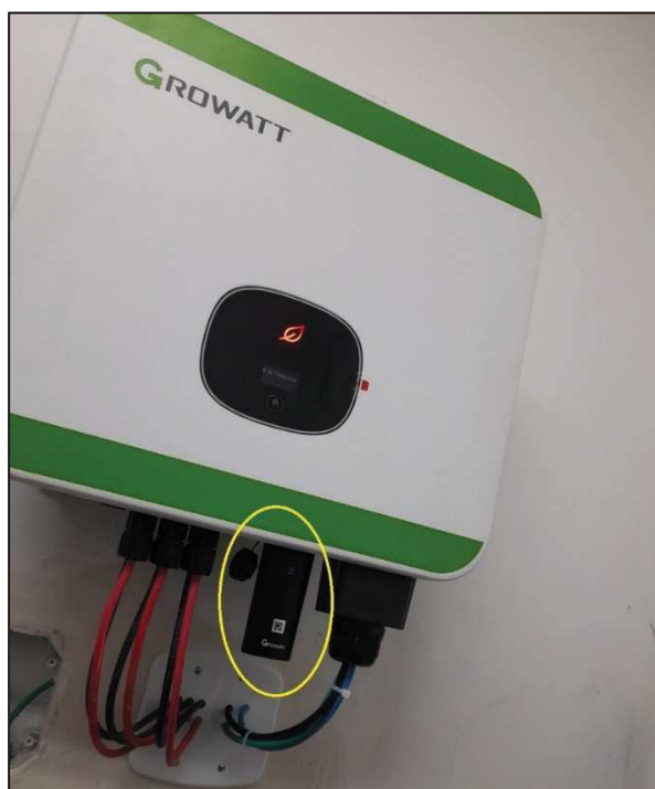
Figura 38. Conexão do moldem no inversor (em amarelo).
