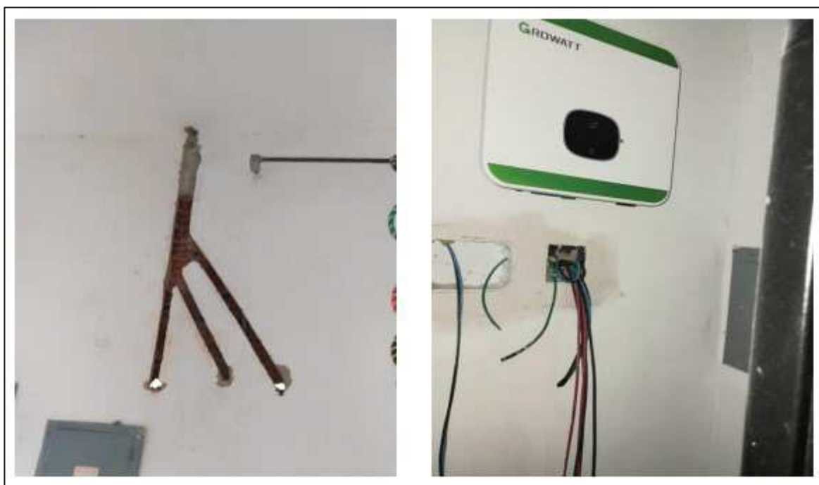
Figura 33. Demarcação da passagem dos eletrodutos (a) e instalação do inversor (b).
