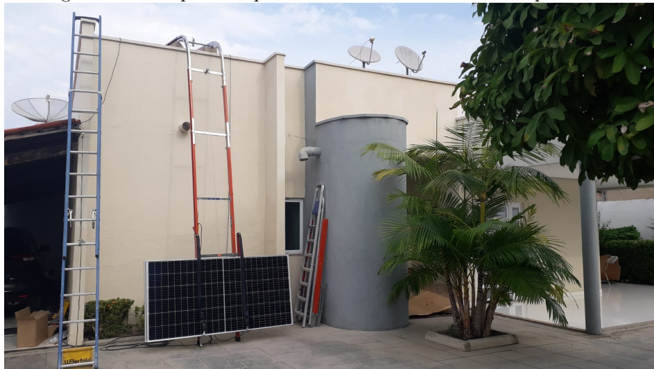
Figura 10: Transporte de painéis com elevador motorizado tipo escada.
