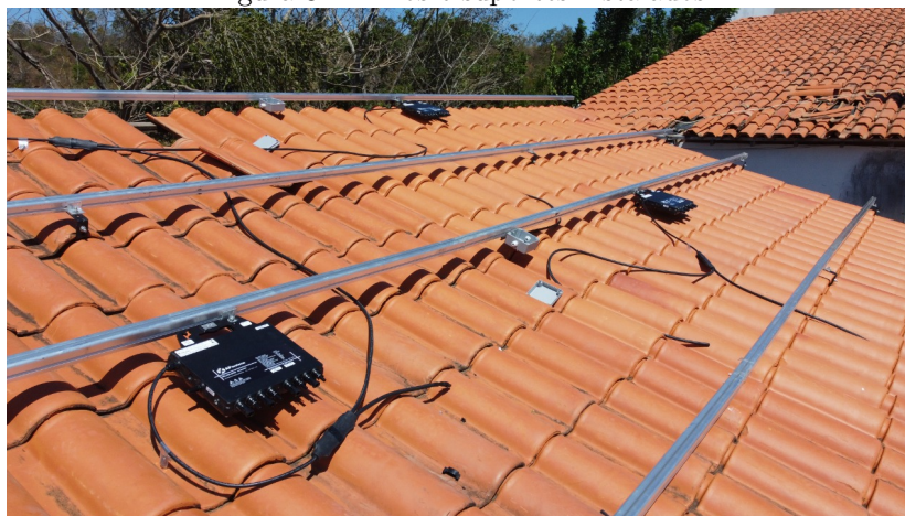
Figura 8: Trilhos e suportes instalados.
