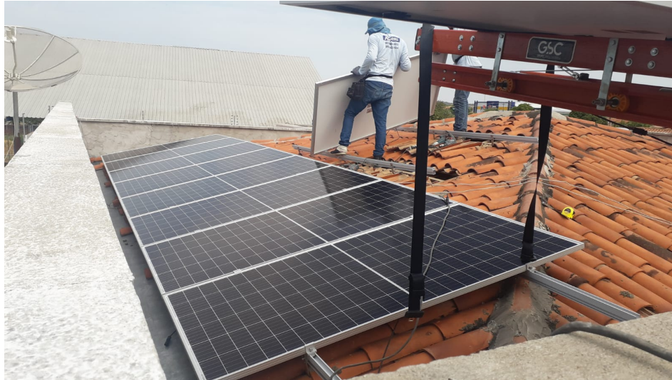
Figura 9: Instalação dos módulos.
