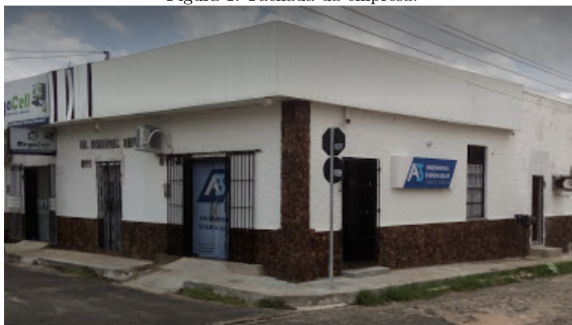
Figura 1: Fachada da empresa.
