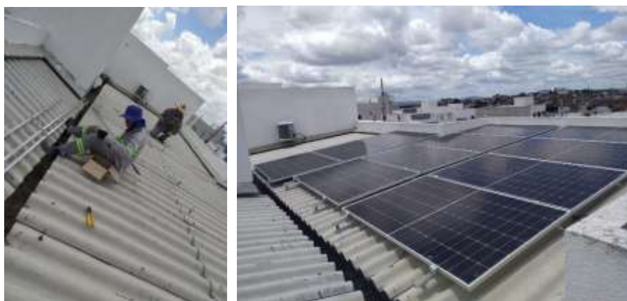
Figura 10 – Fixação dos painéis
