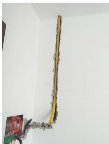
FIGURA 21 - ELETRODUTO INSTALADO
