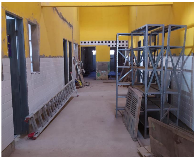
Figura 13 - Reforma da Escola José Lins Sobrinho
