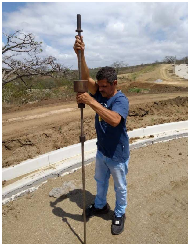
Figura 20 – Execução do ensaio de CPD
