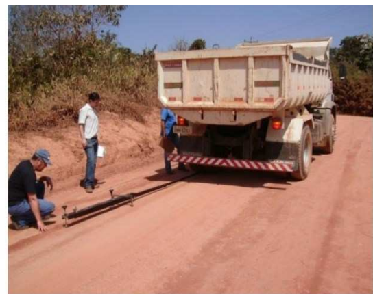
b) Realização do ensaio
