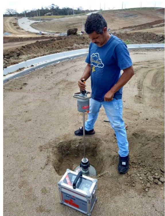
b) Ensaio em uma vala de inspeção
