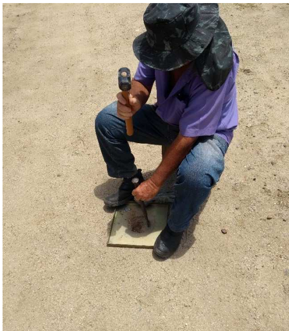
a) Abertura do furo
