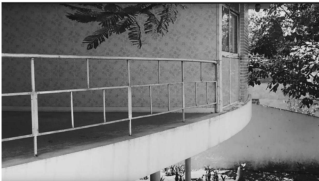
Figura 78 - Peças azulejares locadas na fachada da obra.
