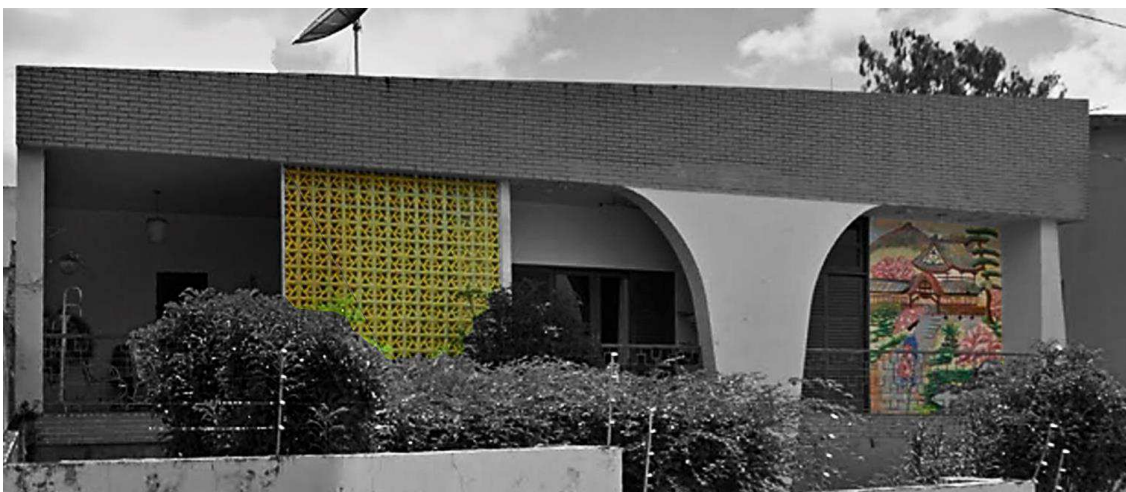
Figura 5 - Residência moderna em Campina Grande-PB com destaque de cor no cobogó e no painel azulejar.
