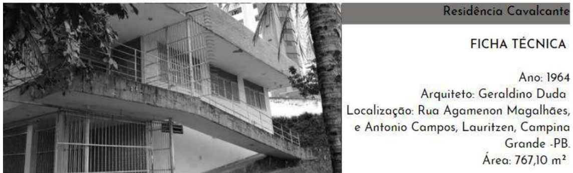
Figura 140 - Foto da fachada e ficha técnica da residência
