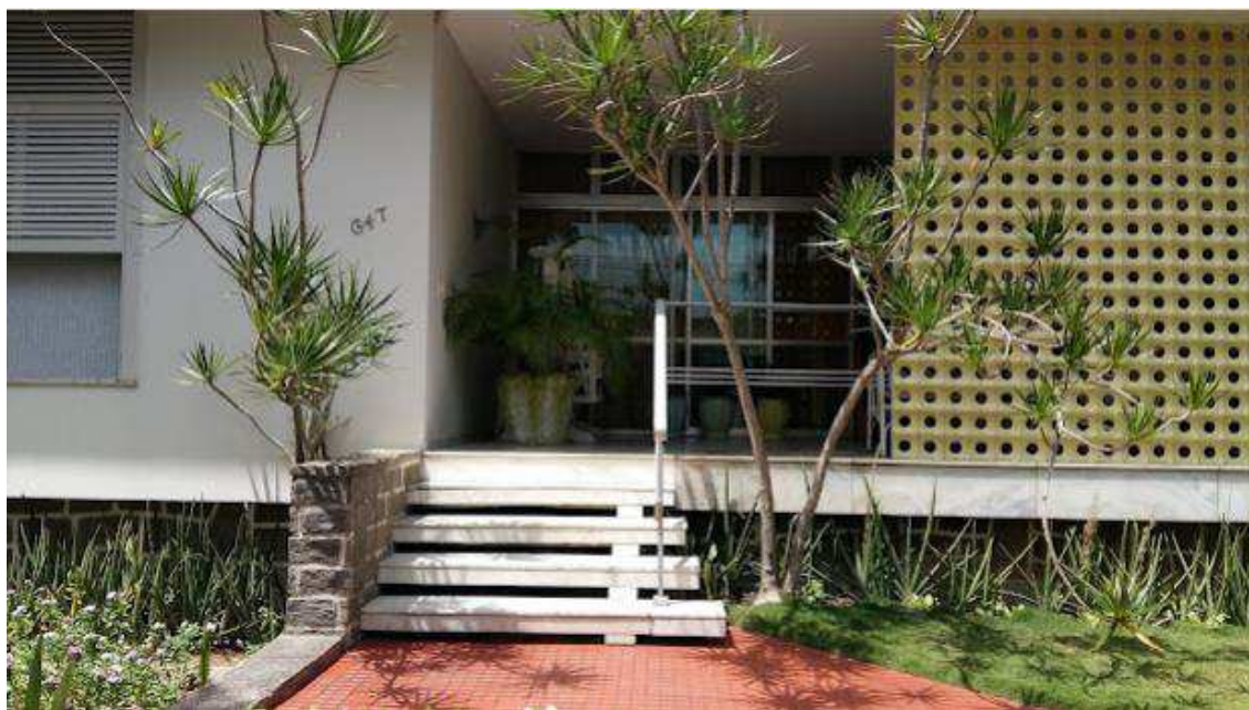
Figura 115 - Fachada com pele de cobogó.
