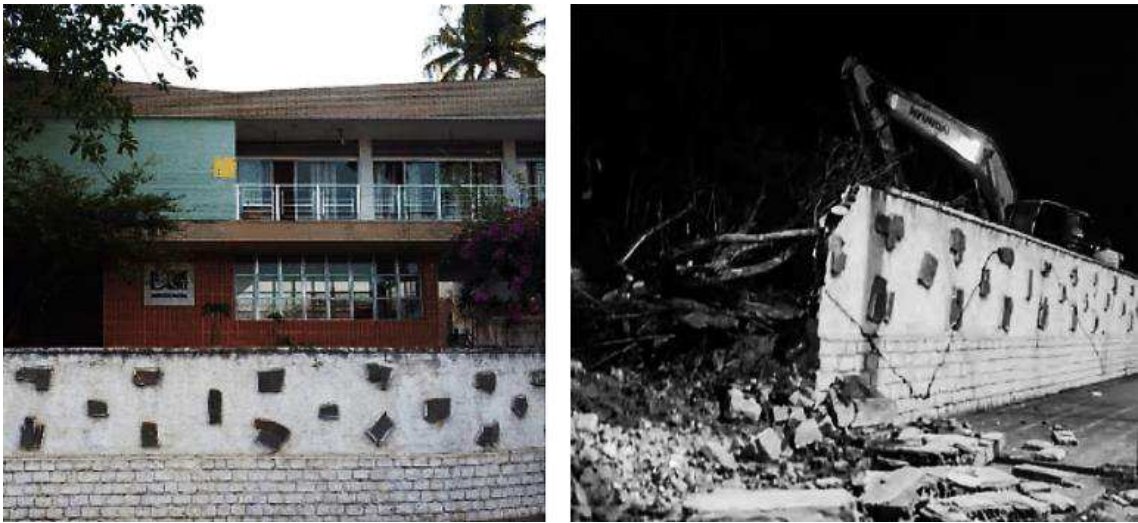
Figura 14 - Residência Raymundo Alves antes e depois do processo de destruição irregular.
