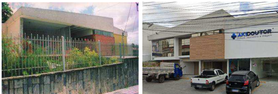
Figura 173 - Residência antes e depois da reforma.
