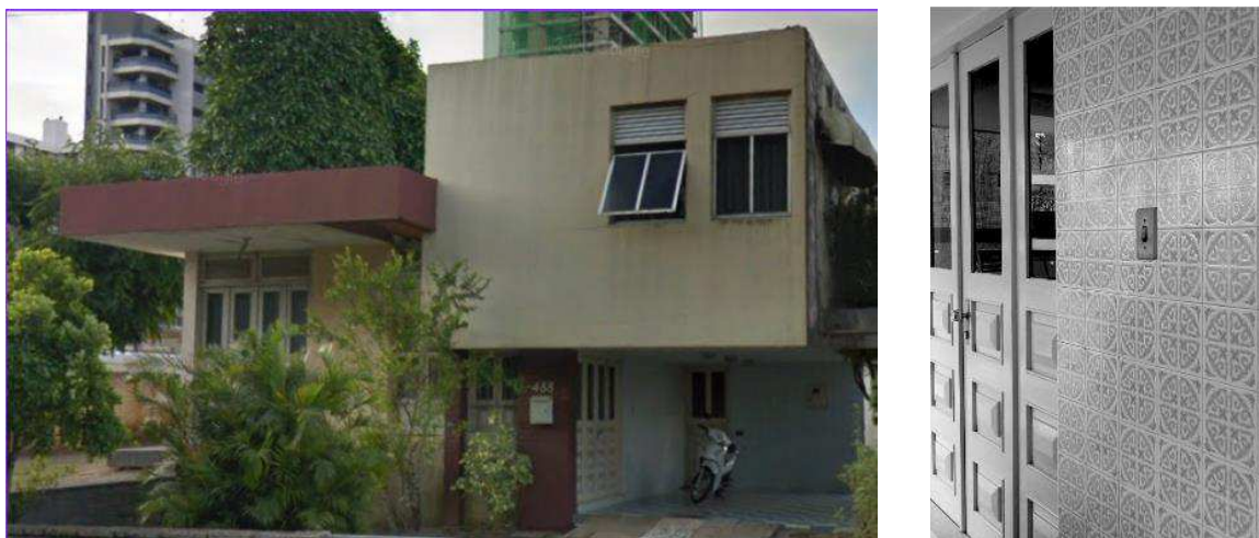
Figura 233 - Fachada principal da residência e detalhe da face azulejar na fachada.
