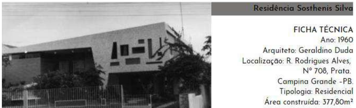
Figura 60 - Fachada principal e ficha técnica da residência Sosthenis Silva.
