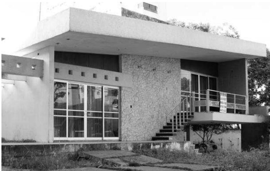
Figura 102 - Fachada da edificação.
