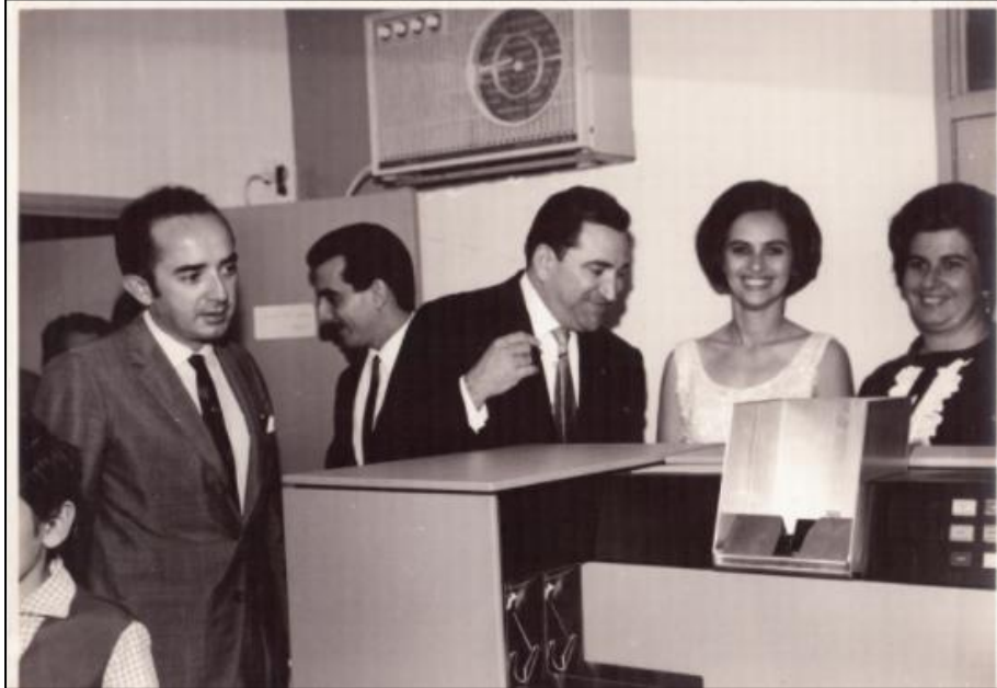
Figura 3 – Instalação do Computador IBM 1130, UFPB (1968)
