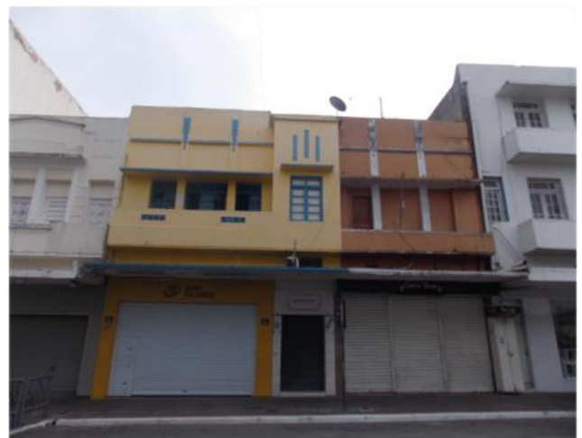
5 RUA MACIEL PINHEIRO
