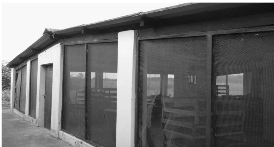
Figura 2. Secador natural de material vegetal.
