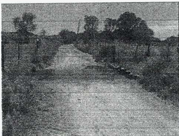
Foto 26: Construção de passagem molhada em estrada que liga Boqueirão a Moreira de Cima.
