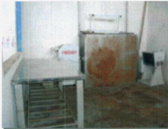
Foto 13 - Equipamentos nunca utilizados
