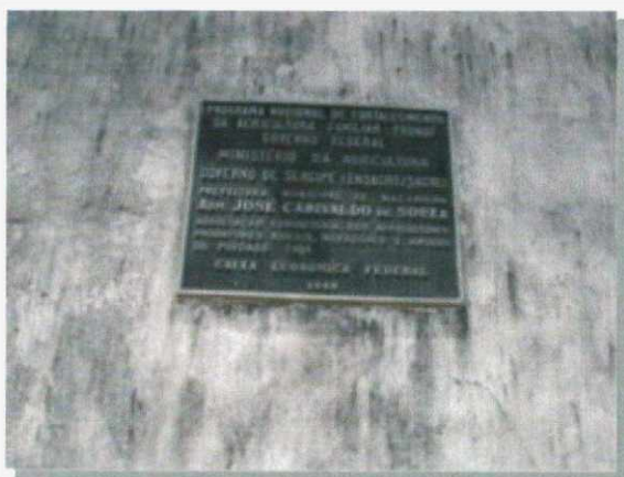
Foto 6 - Placa de identificação da construção
