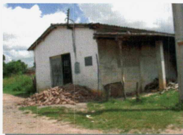
Foto 7 - Casa de Farinha em operação
