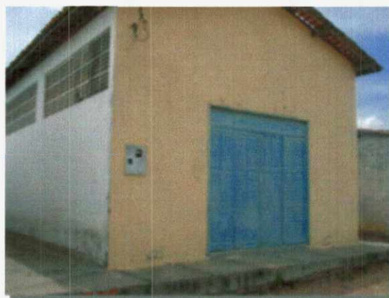
Foto 15 - Fachada do prédio
