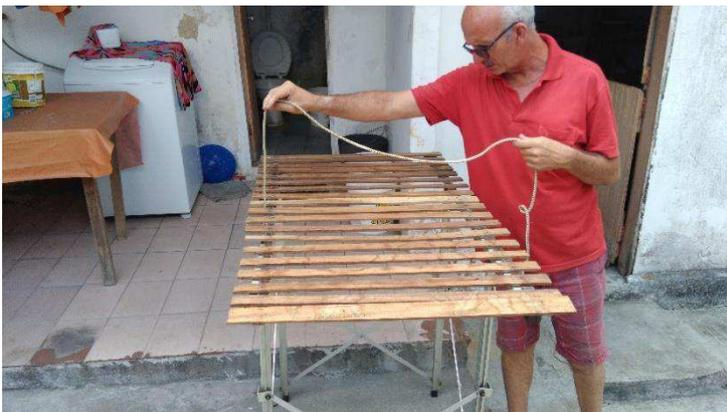
Figura 24: Fixação do tampo na estrutura.
