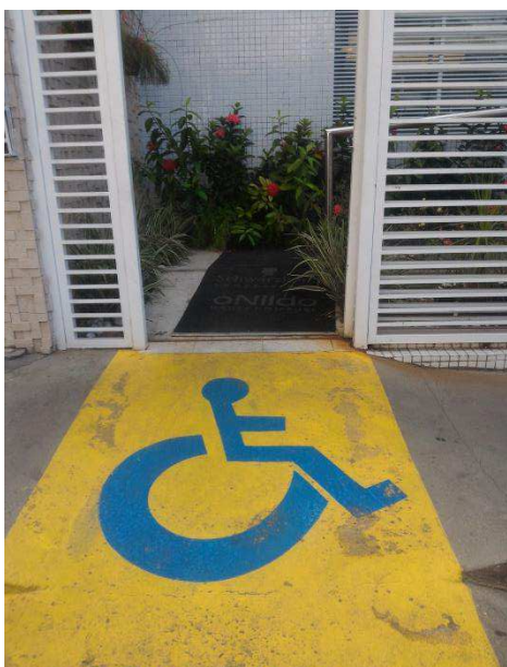
Figura 11: salão de Campina Grande com acessibilidade. Fonte: próprio autor.
