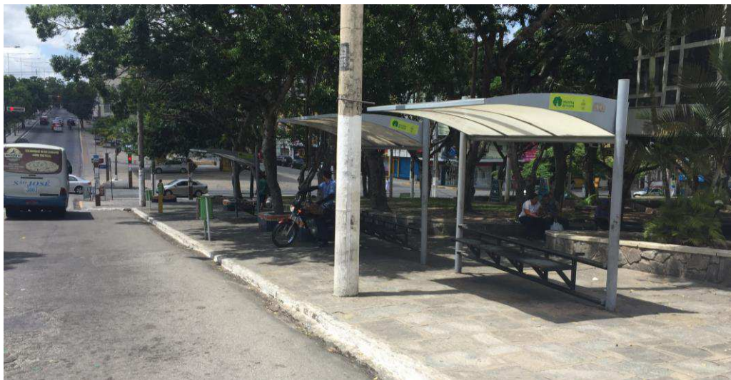
Figura 17: Situação atual dos abrigos implantados na Praça Clementino Procópio.
