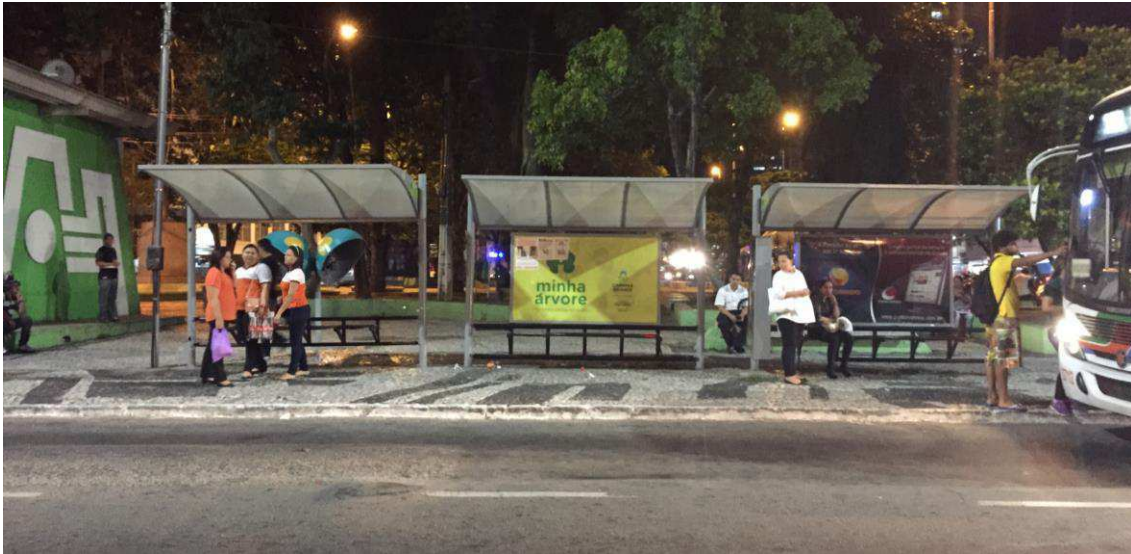
Figura 15: Exemplo de abrigos fora da especificação quanto à distância entre eles - Praça da Bandeira
