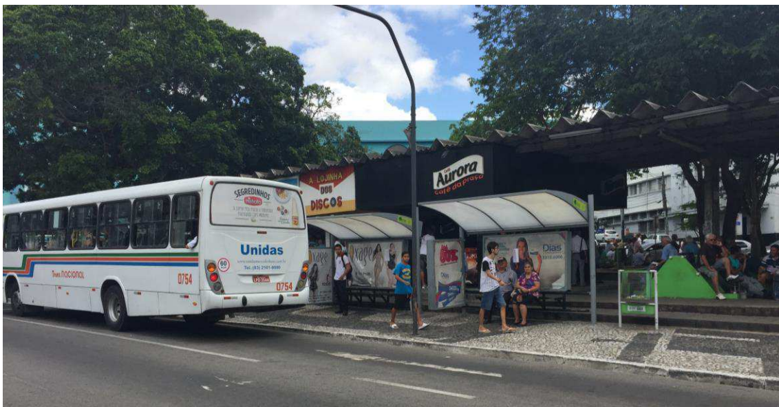
Figura 16: Exemplo de abrigos implantados incorretamente.
