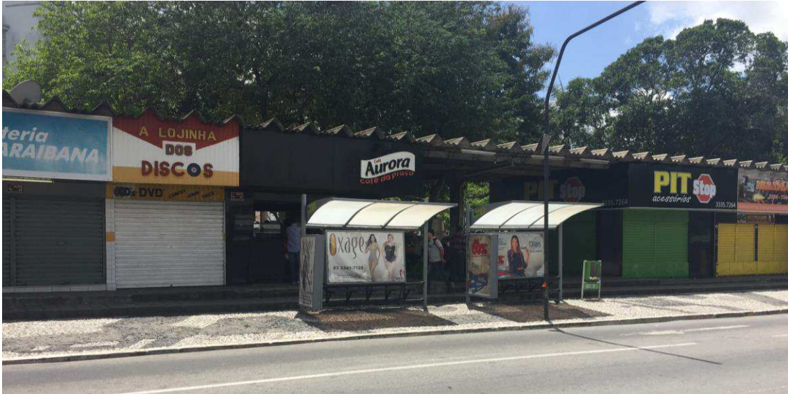
Figura 19: Situação atual dos abrigos implantados junto à escadaria da edificação.
