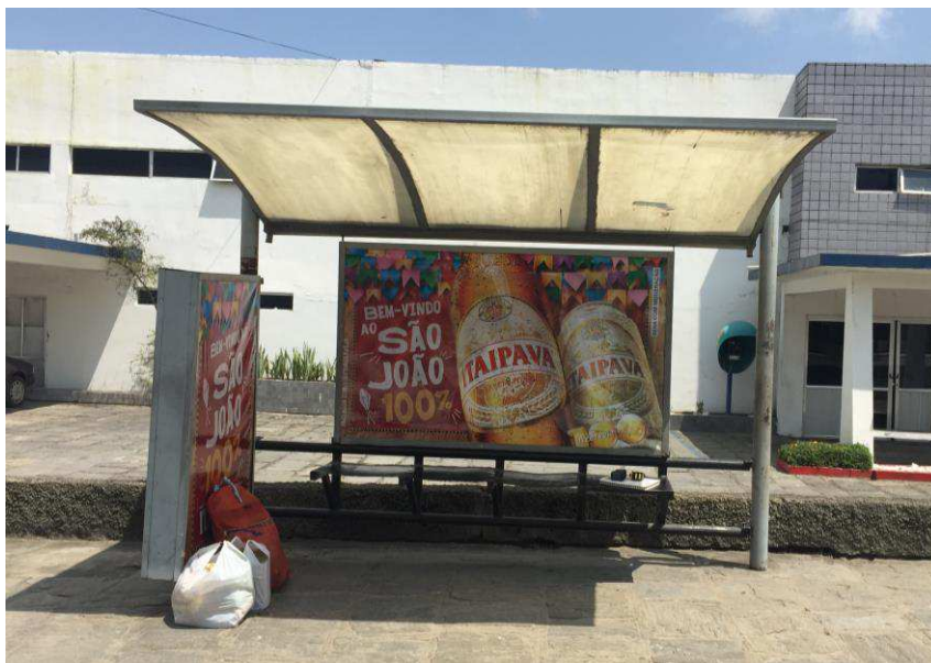
Figura 04: Abrigo para usuários de transporte público em metal.
