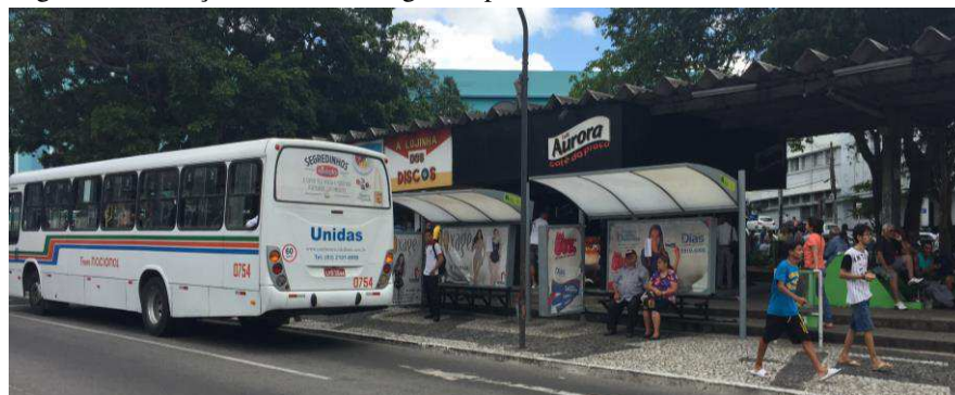
Figura 06: Situação atual dos abrigos empantanados na cidade.
