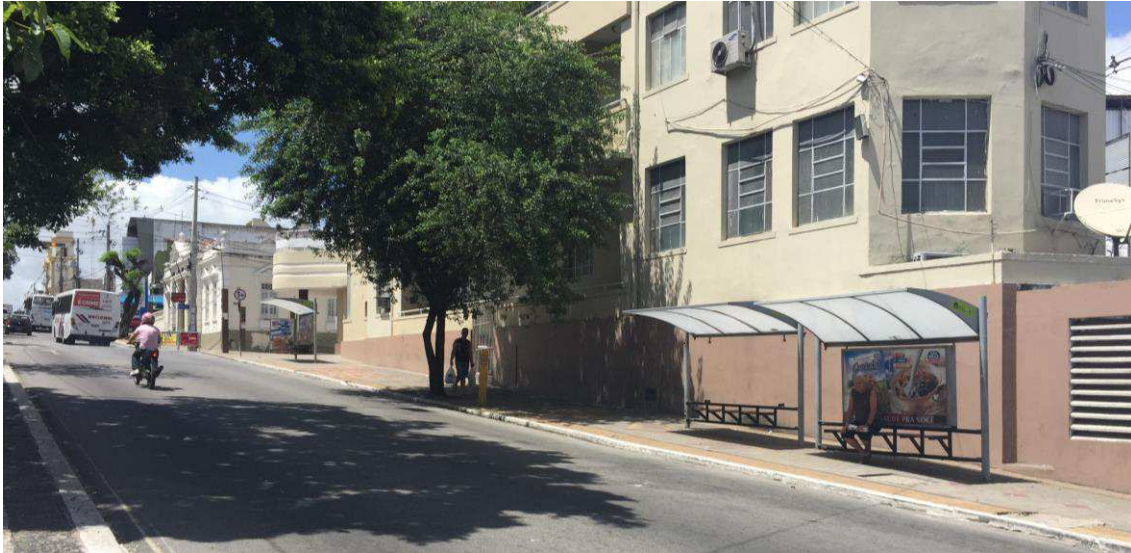
Figura 18: Situação atual dos abrigos implantados na calçada da Prefeitura Municipal de Campina Grande.
