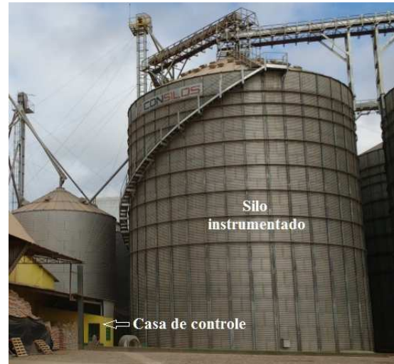
Figura 51. Instalação do sistema de aquisição de dados: Montagem (A); Localização da casa de controle em relação ao silo instrumentado (B).
