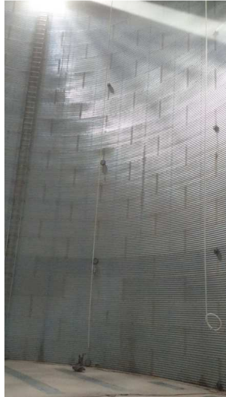
Figura 48. Instalação das células na parede do silo: Alinhamento vertical P1 sendo executado (A); Alinhamentos verticais P1 e P2 prontos (B).
