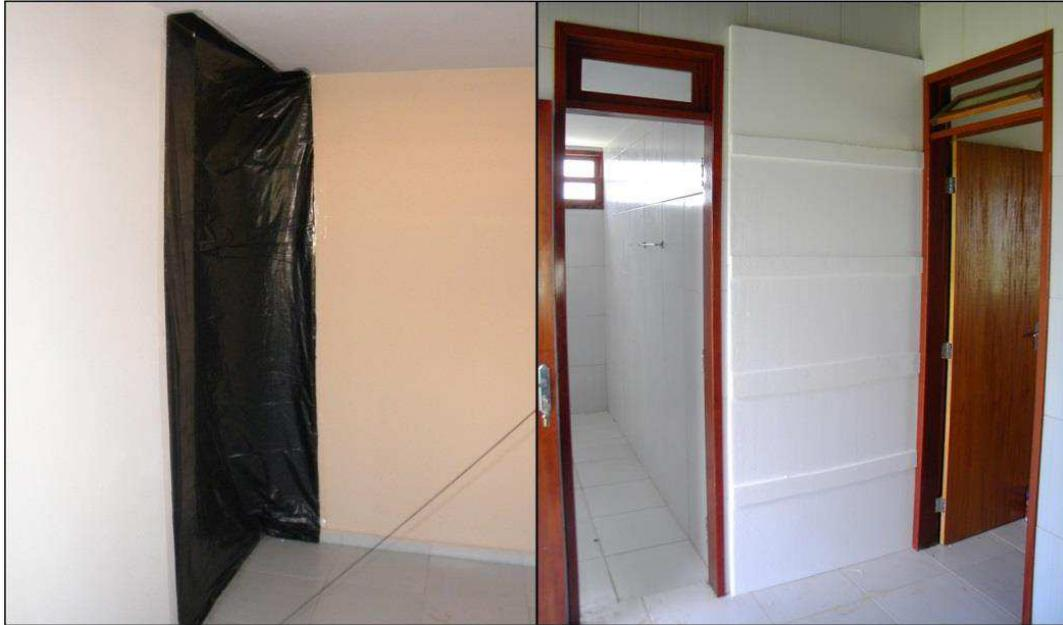
Figura 79- Vedação do vão de comunicação entre sala e cozinha
