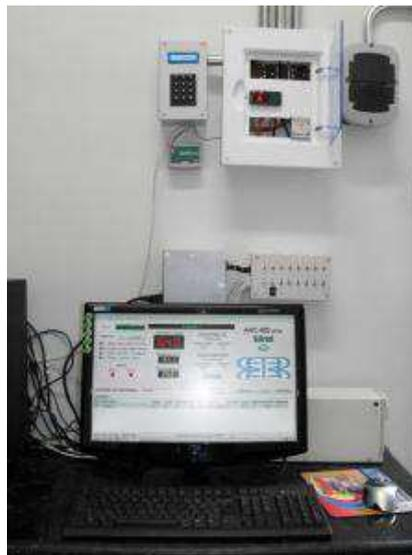
**Figura 8-** Sistema completo de monitoramento da câmara (SITRAD)
