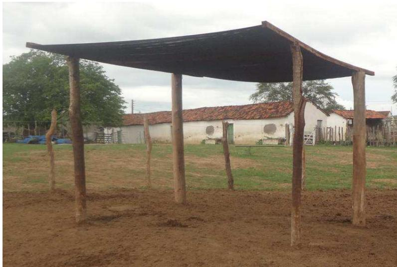
**Figura 4:** Vista da estrutura de madeira com cobertura de malha de polipropileno sombrite a 80%
