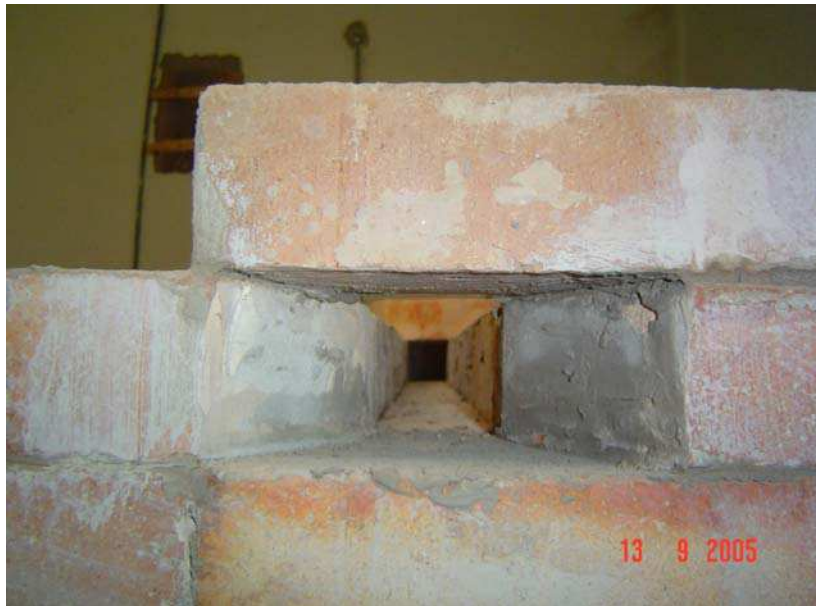
Figura 3.3 – Foto da construção do forno, mostrando uma entrada para queimador. Fonte: Próprio autor (2005).
