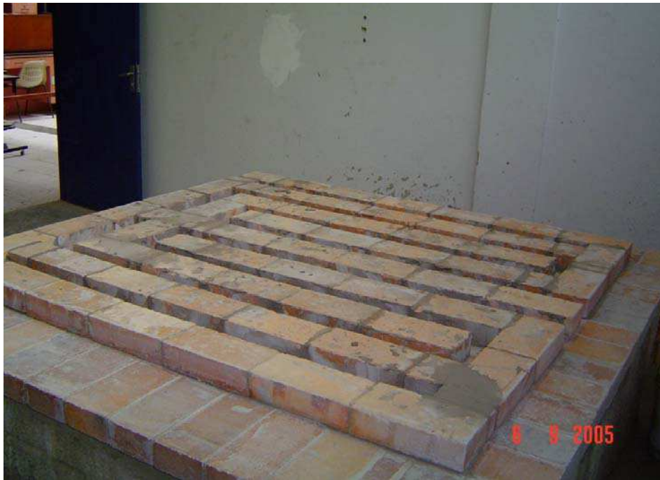
Figura 3.2 – Foto ilustrativa dos canais por onde o gás é distribuído de forma homogênea. Fonte: Próprio autor (2005).
