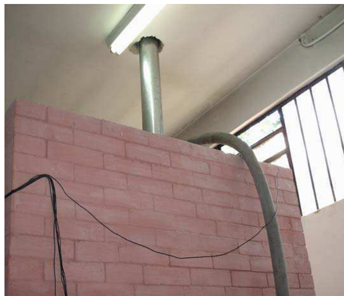
Figura 3.23 – Tubo do compressor levando ar frio para chaminé. Fonte: Próprio autor (2007).
