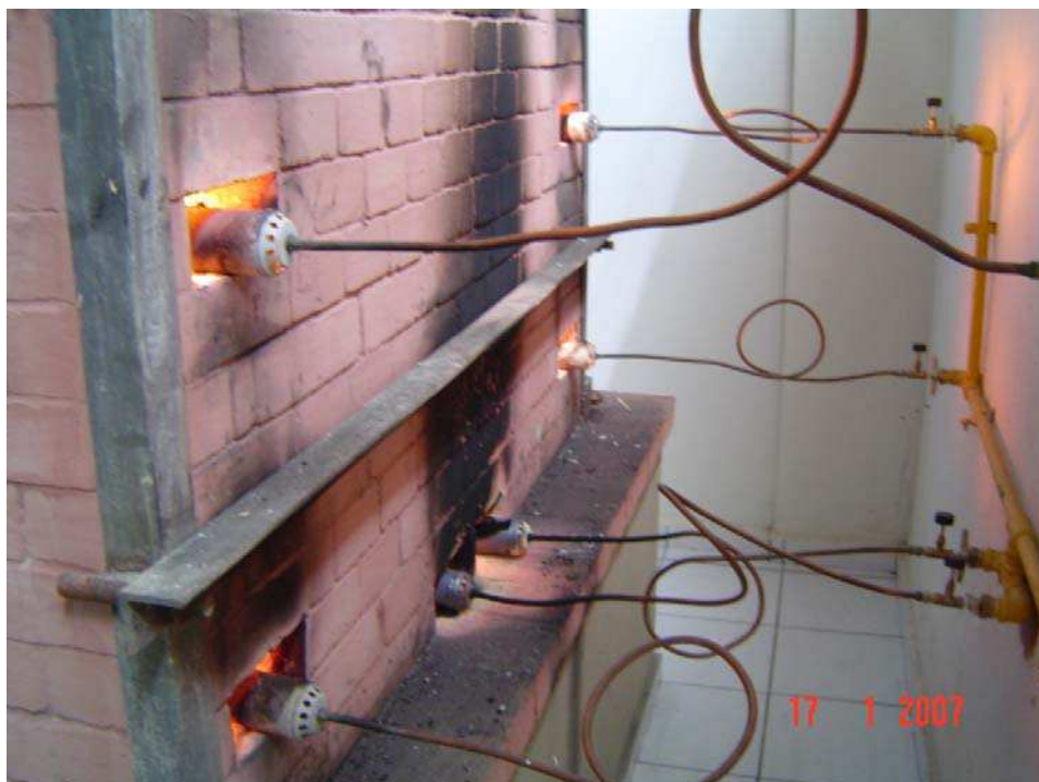
Figura 3.11 – Vista dos seis queimadores operando com gás natural. Fonte: Próprio autor (2007).
