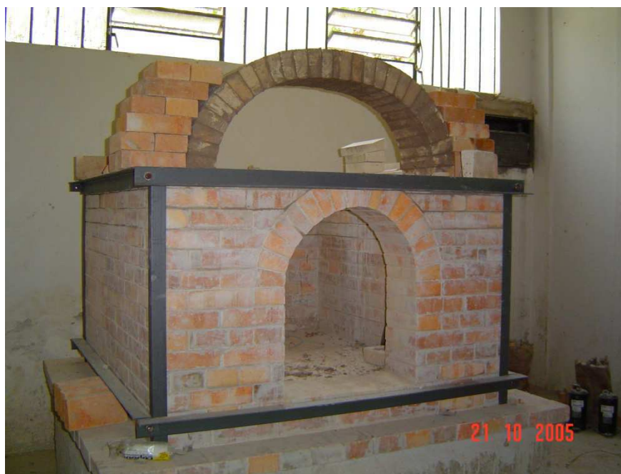
Figura 3.7 – Construção da parte superior do forno secador. Fonte: Próprio autor (2005).
