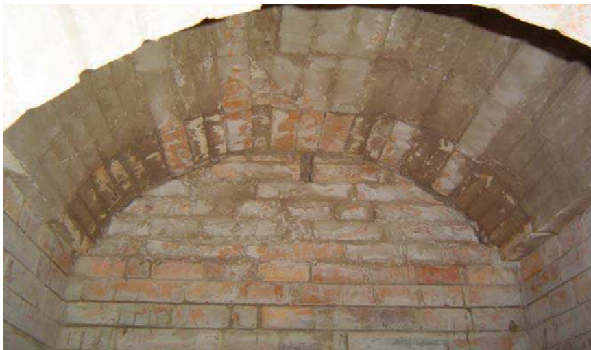
Figura 3.4 – Vista do interior do forno (teto em forma de abóbada). Fonte: Próprio autor (2005)
