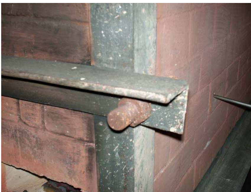
Figura 3.6 – Cantoneira de ferro para reforço forno/secador. Fonte: Próprio autor (2005).
