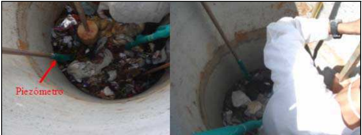
Figura 25 – Detalhe da instalação do piezômetro.
