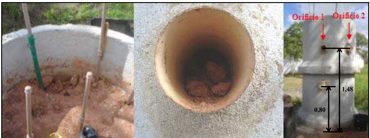
Figura 56 – Presença do solo de cobertura no orifício 1 e abertura do orifício 2.
