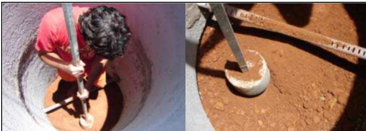
Figura 21 - Sistema de impermeabilização de base executada por meio de compactação manual.
