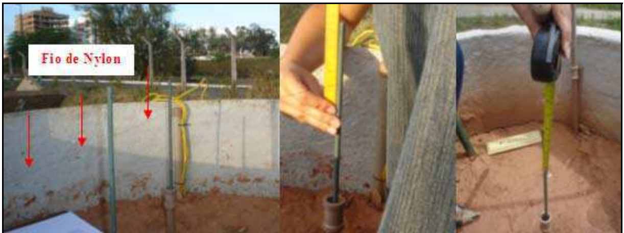
Figura 69 – Medição do deslocamento vertical das placas de recalque.
