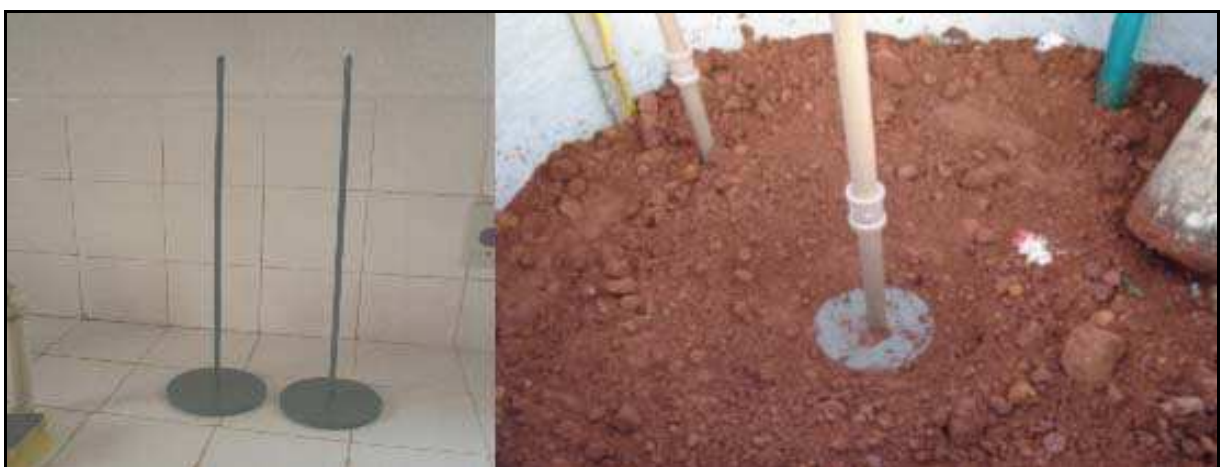
Figura 26 - Detalhe das placas de recalque superficiais e instalação.
