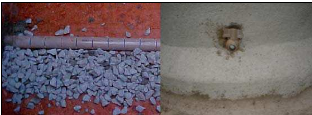
Figura 22 - Sistema de drenagem de base para lixiviado.
