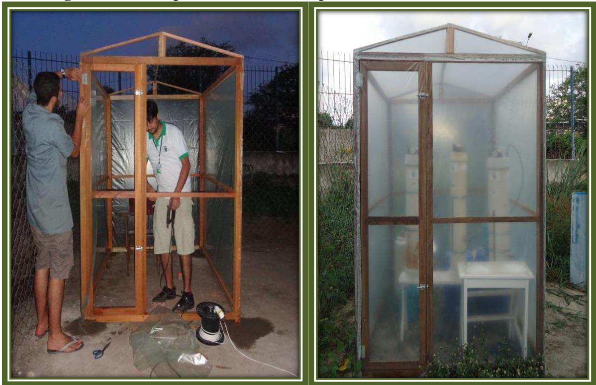
Figura 20: Estufa para aumento da temperatura interna dos biorreatores
