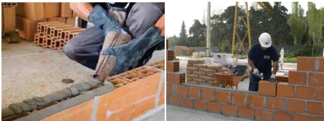
Figura 2.5 – Utilização de argamassa de assentamento na confecção de parede de alvenaria
