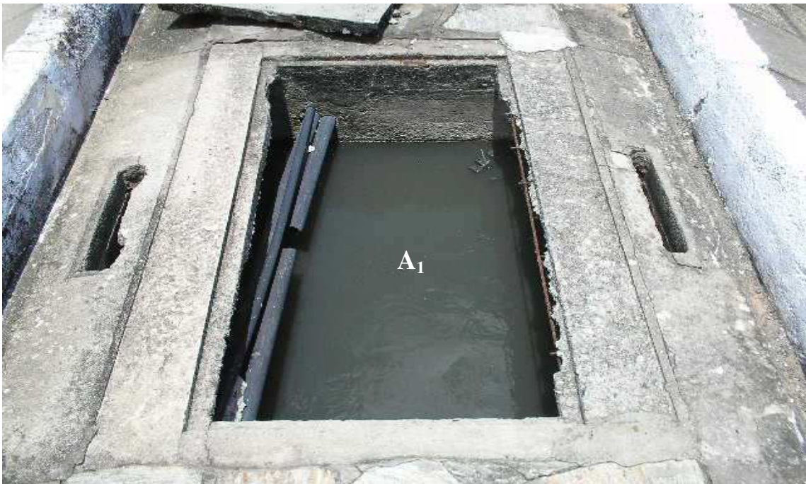
Figura 4.7 - Canal de passagem C 1 .
