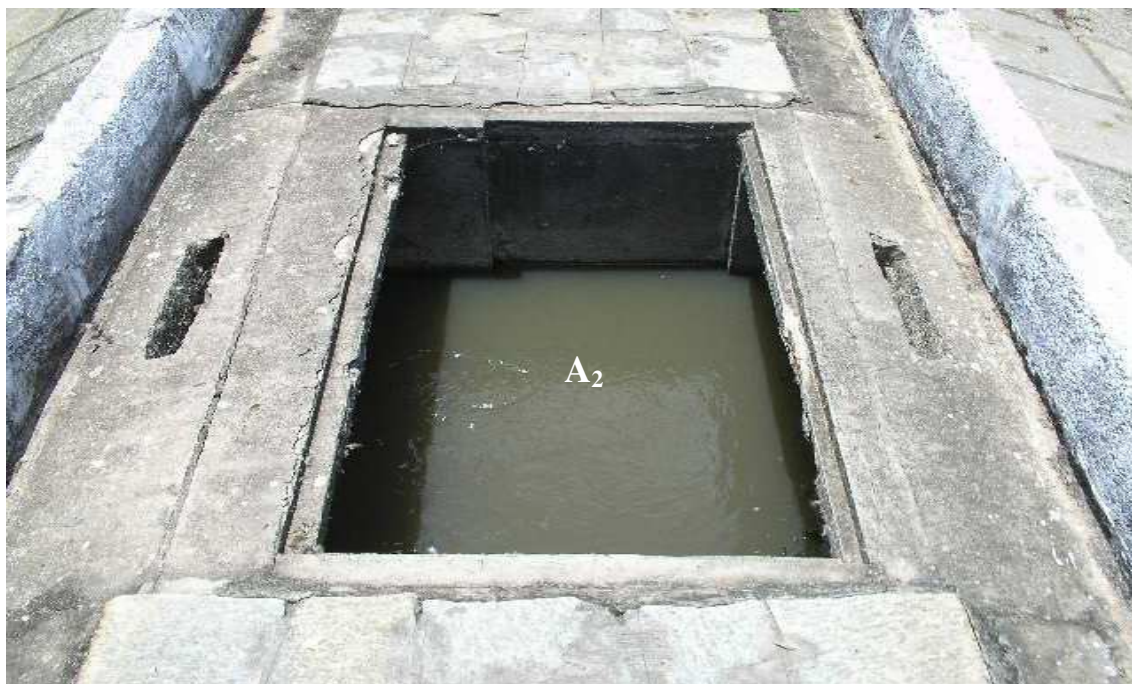
Figura 4.8 - Canal de passagem C 2 .
