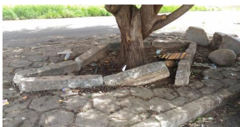
Figura 7. Sistema radicular danificando o calçamento da praça.
