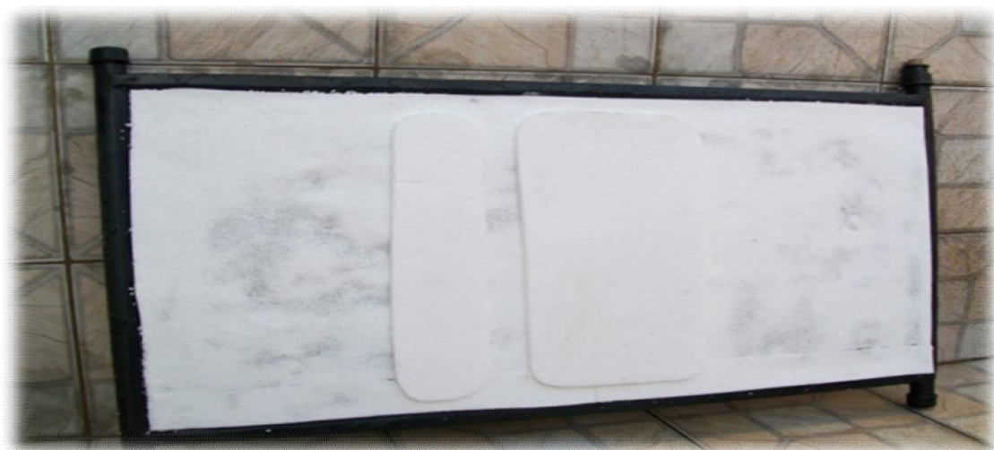
Figura 7. Aplicação do isolamento térmico.
