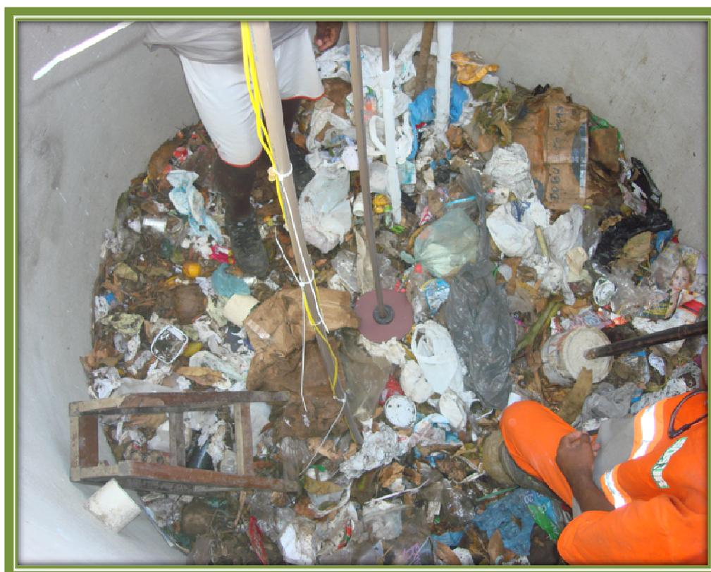
**Figura 31: Preenchimento do biorreator**
