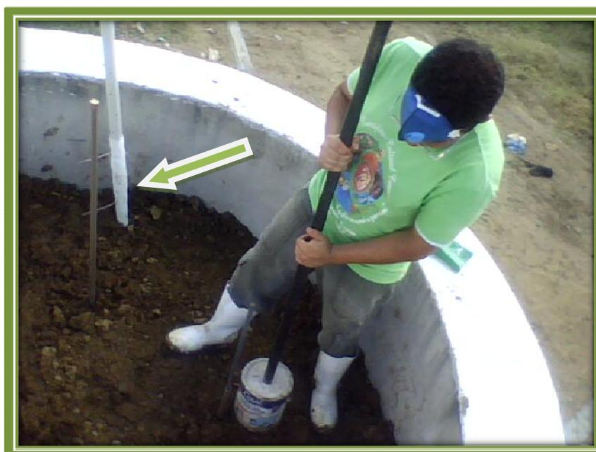
Figura 21: Tubo de drenagem de gás
