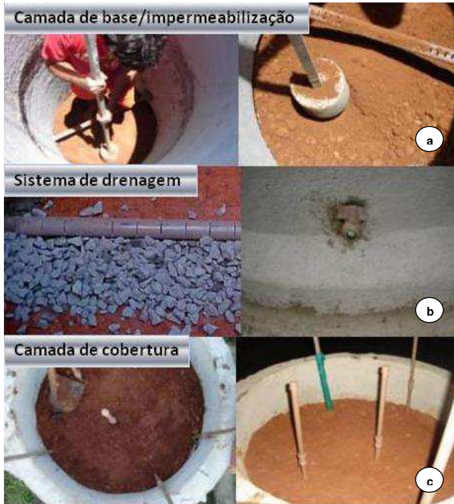
Figura 11: Impermeabilização, drenagem e camada de cobertura do lisímetro.
