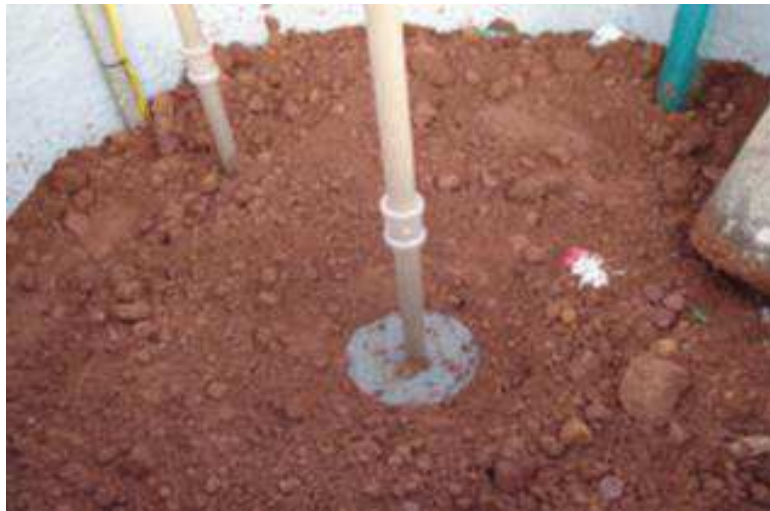
Figura 14: Placas para medição de recalque.
