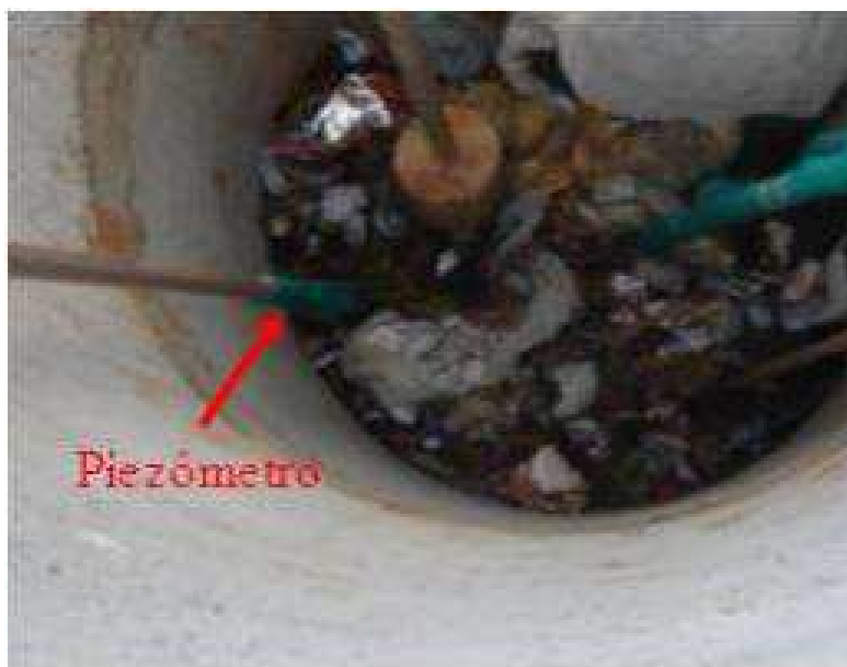
Figura 13: Instalação do piezômetro no lisímetro.
