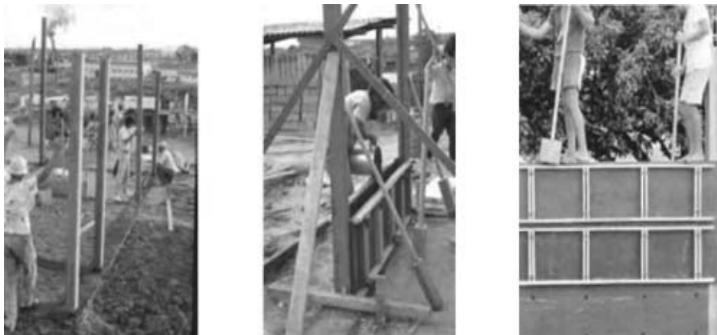
Figura 2.7: Colocação das guias verticais, montagem das formas e compactação. (Fonte: CAMPOS, 2007)
