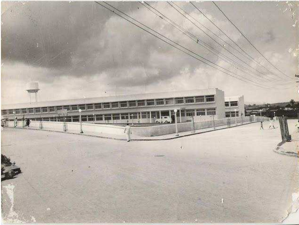
Figura 22 – A Maternidade Municipal finalizada
