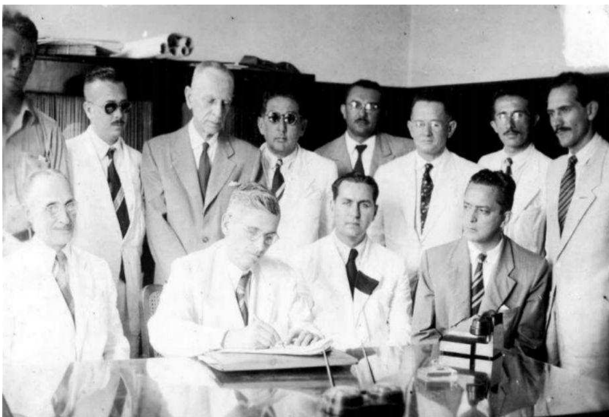
Figura 17 – Assinatura do Contrato para Construção da Maternidade Municipal
