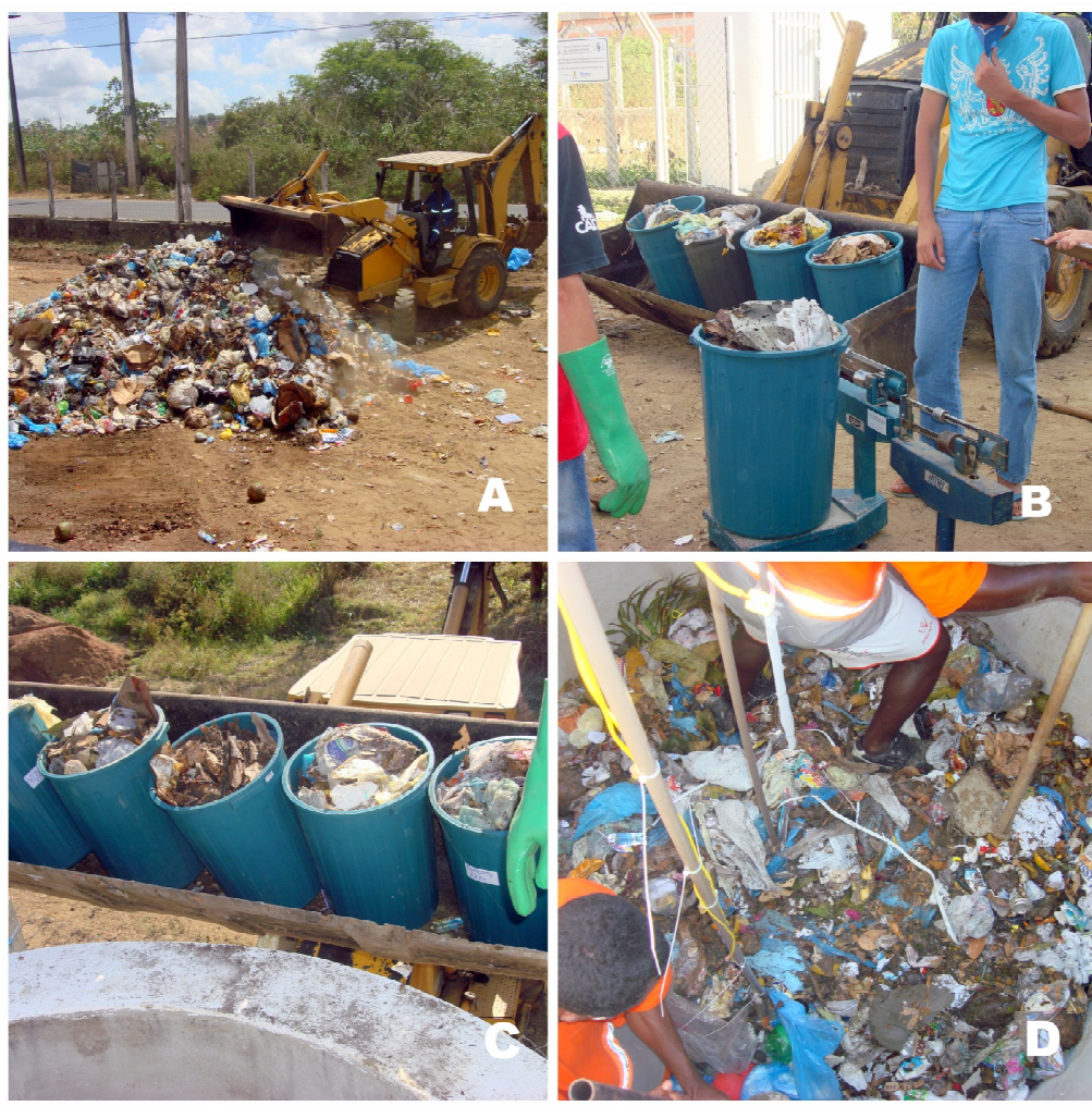
Figura 16 - A= Homogeneização dos RSU; B = Pesagem dos resíduos a serem acondicionados; C = RSU levado até a borda da Célula Experimental; D = Acomodação e compactação dos resíduos.
