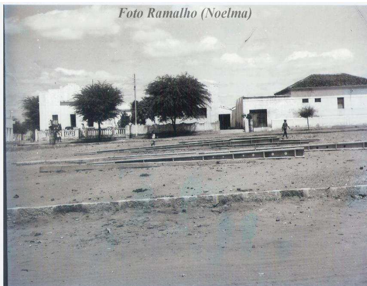
Figura 10 – Postes no chão da Rua Velha para a implantação da distribuição elétrica Fonte – Noelma Ramalho. (acervo pessoal)
