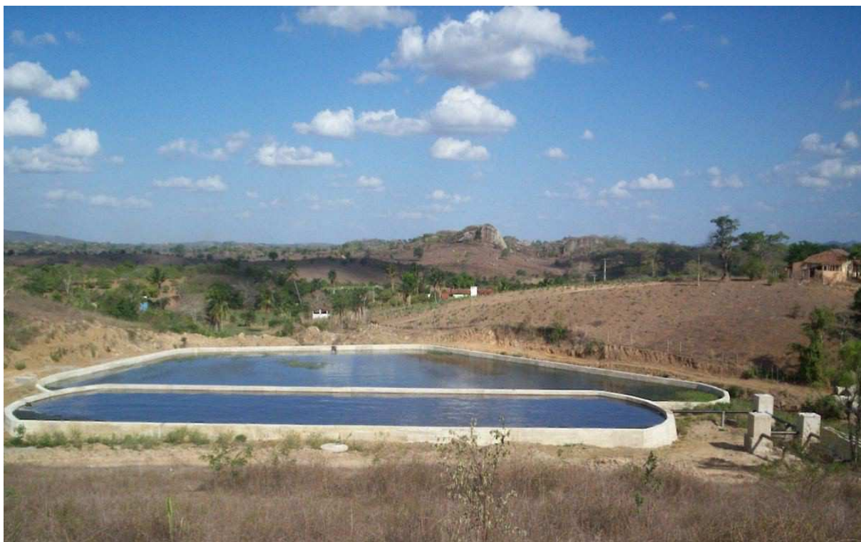
Figura 4.13 – Vista geral das lagoas que compõem sistema de tratamento de esgotos
