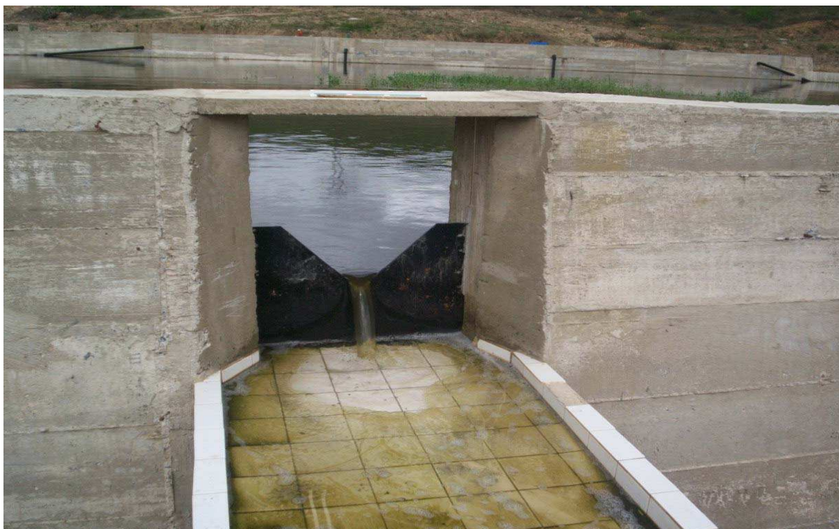
Figura 4.14 – Efluente escoando pelo vertedor triangular
