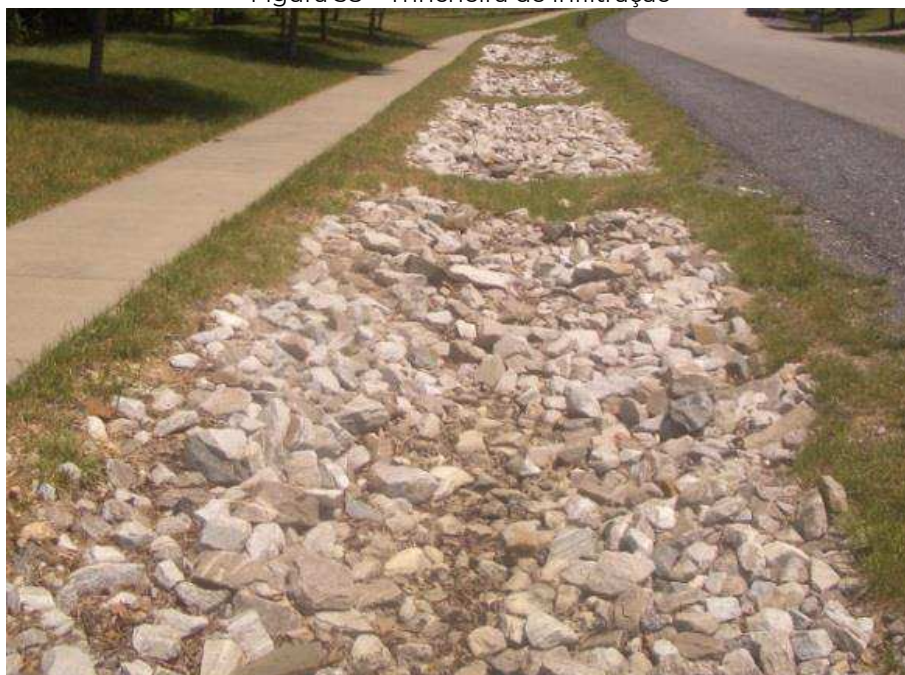
Figura 38 – Trincheira de infiltração
