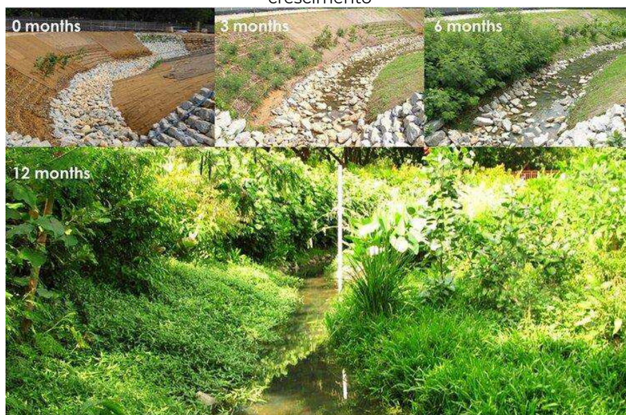
Figuras 13, 14, 15 e 16 – Testes de bioengenharia monitorando a progressão, estabilidade e crescimento
