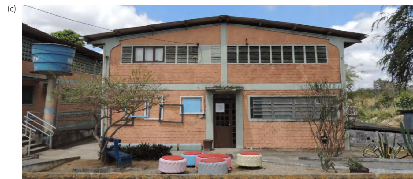
Fig. 101 | (a) ampliação em imagem de satélite do setor B (UFMG); (b) visão geral conjunto de galpões do setor B; (c) Bloco BU. Fonte: (a) adaptado de dados base da Seplan-PMCG (2010) pelo autor, 2021; (b,c) Autor, 2019.
