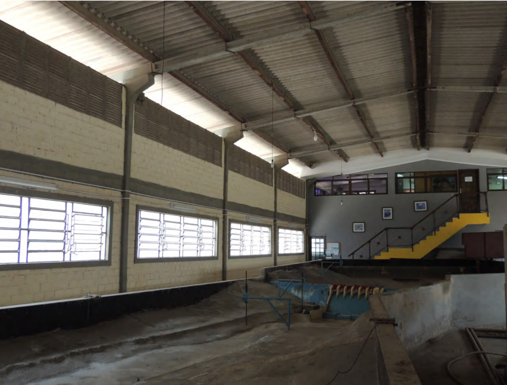
Fig. 107 | Detalhe do pórtico (pilar e viga) pré-moldado do sistema PL utilizado no loco BU. Fonte: Autor, 2021.
