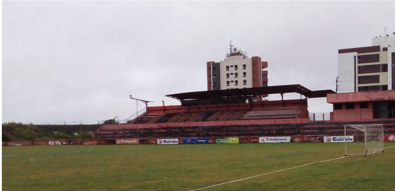
Fig. 82 | Composição imagética da estrutura de arquibancadas do Campinense Clube. (a) vista geral; (b) arquibancadas setor norte; (c) estrutura pré-moldada de cobertura das arquibancadas. Fonte: Luma Gomes, 2021.
