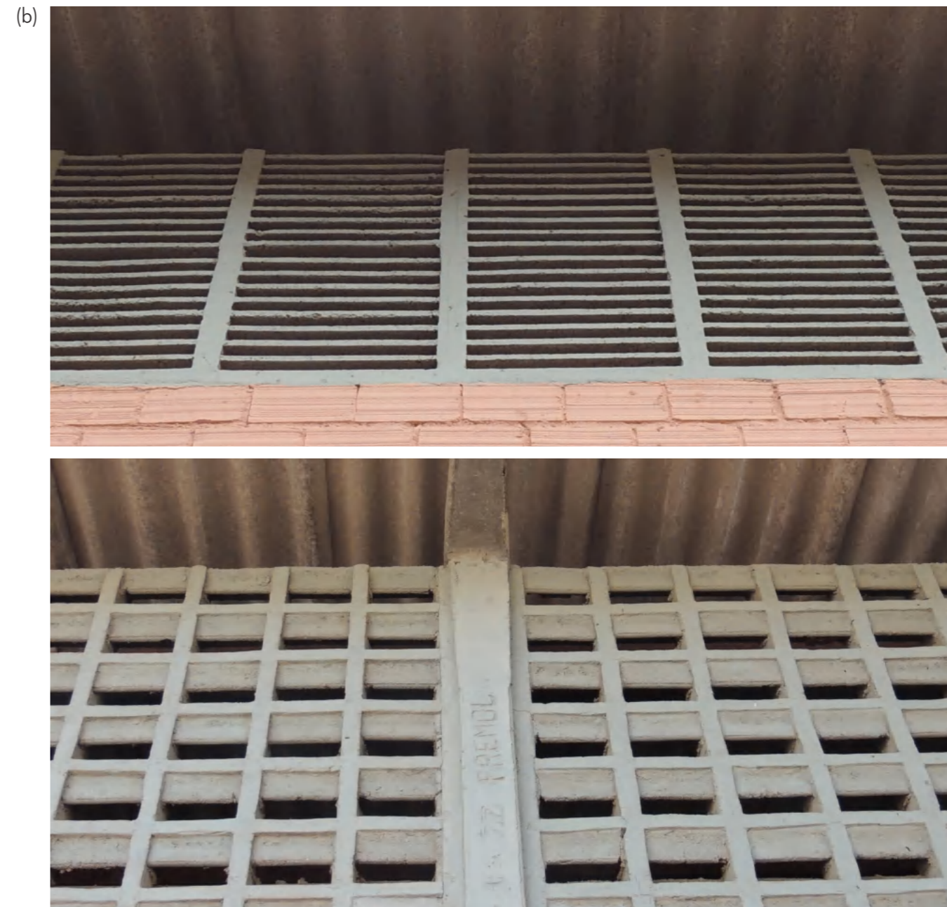
Fig. 112 | (a) perspectiva externa do Bloco BU; (b) tipologias de cobogós produzidos pela Premol para os galpões do setor B (UFCG). Fonte: Autor, 2021.
