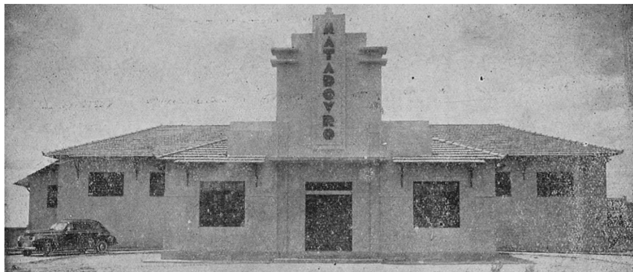
Fig. 45 | (a) Prédio do Matadouro Público, no bairro de Bodocongó (1942); (b) imagem de satélite referente a antiga localização do objeto (07/ 2005). Fontes das imagens: (a) Saulo Araújo - enviado ao blog Retalhos Históricos de Campina Grande / (b) Google Earth Pro, 2021.
