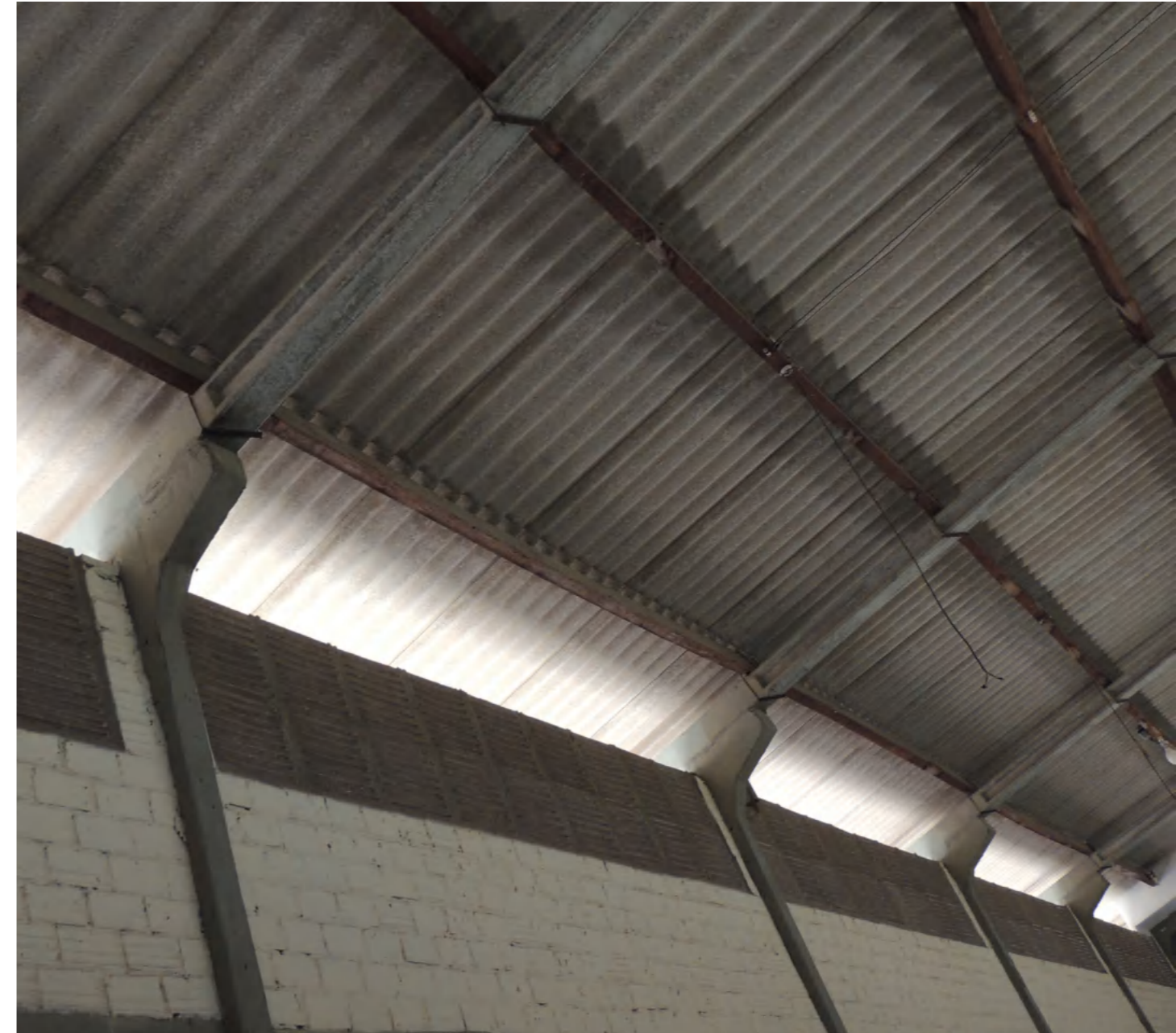
Fig. 108 | Detalhe da interface (viga - pilar) do sistema pré-moldado do bloco BU. Fonte: Autor, 2021.
