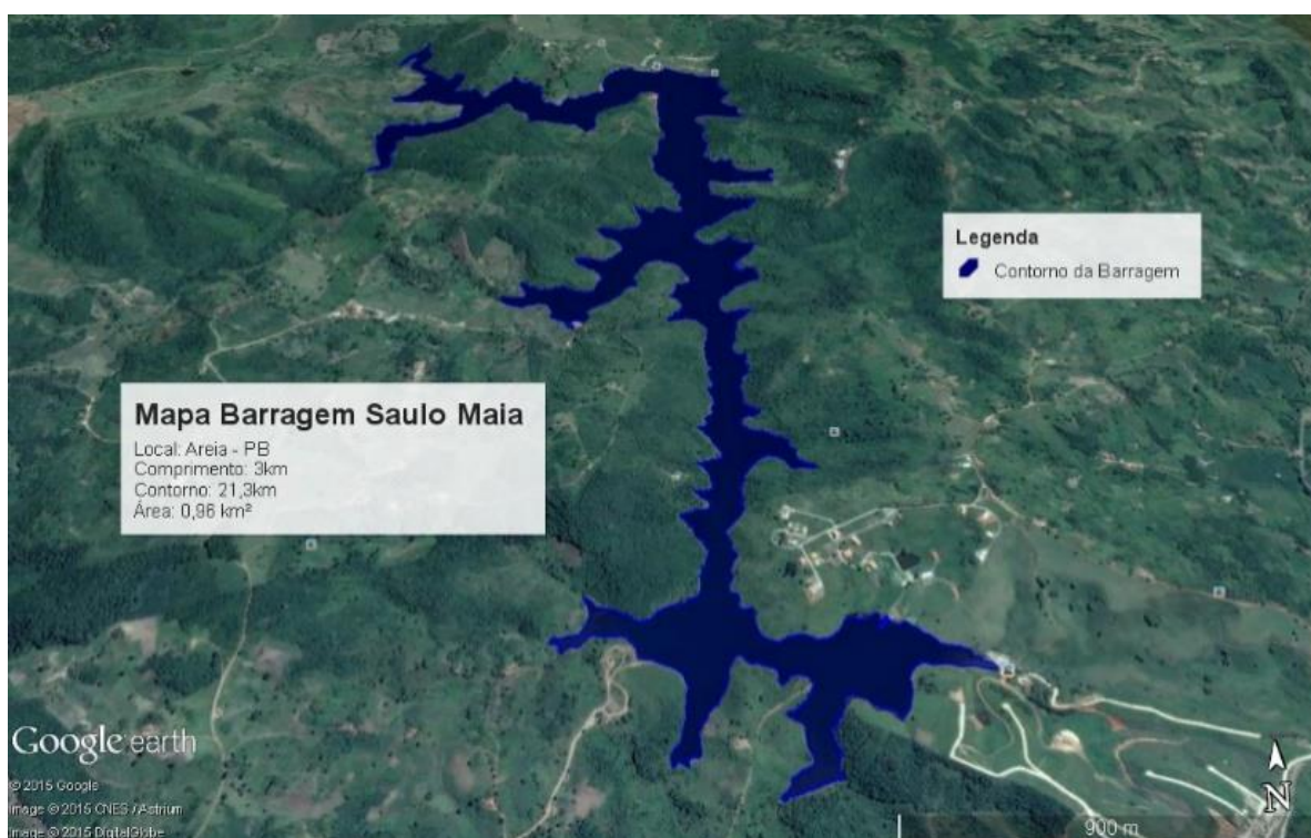
Figura 6. Contorno da Barragem Saulo Maia elaborado no software Google Earth.
